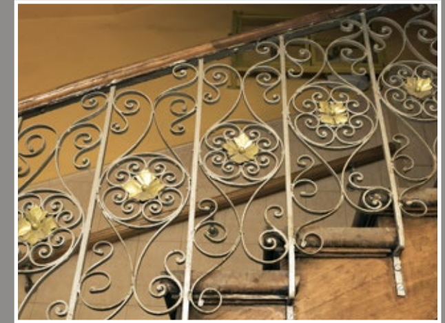
20 Balustrada schodów w kamienicy przy ul. Sowińskiego 1
