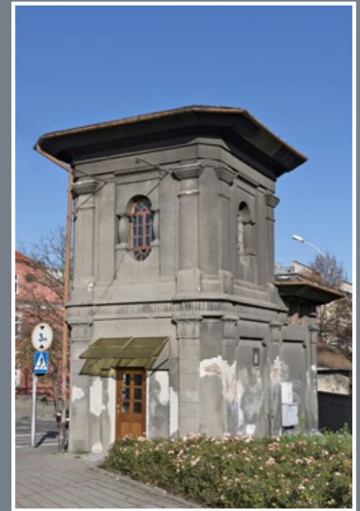
83 Stacja transformatorowa usytuowana na pl. Konstytucji 3 Maja
