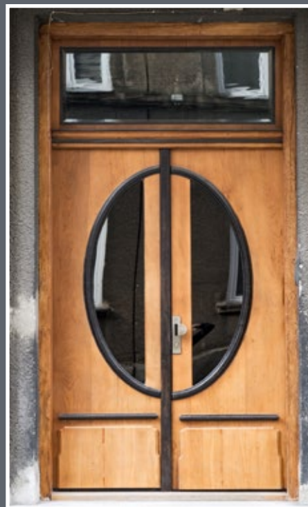
100 Drzwi w modernistycznej kamienicy przy ul. Niewiadomskiego 1
