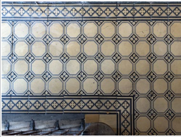
28 Posadzka podestu klatki schodowej w kamienicy przy ul. Kremera 2
