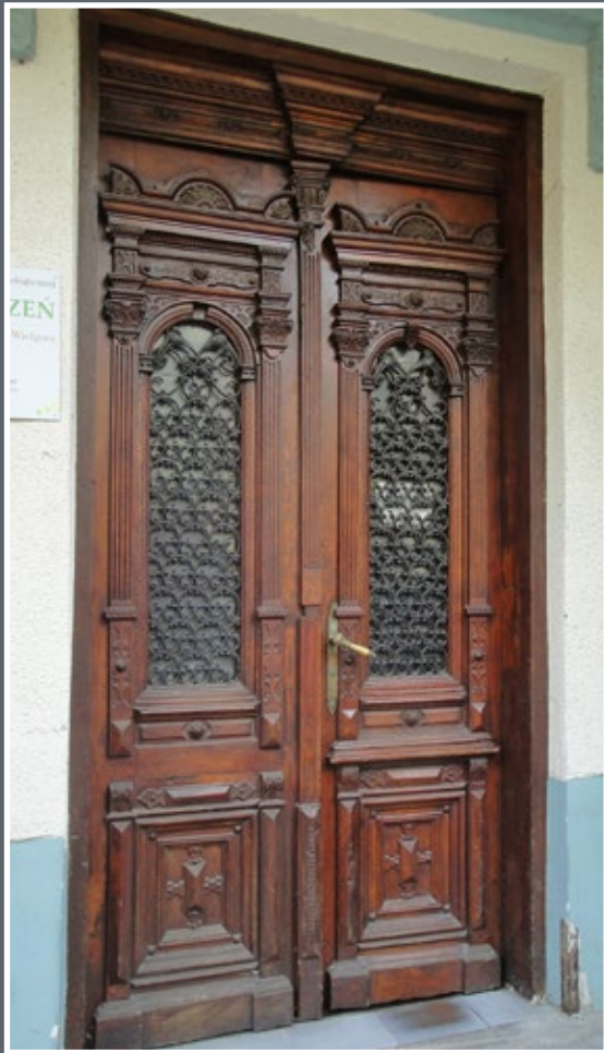
37 Prostokątne, masywne drzwi w willi komendanta korpusu przy ul. Mickiewicza 15 z żeliwną kratą prześwitów ozdobioną głowami orłów oraz zachowanym szyldem zamku z klamką
