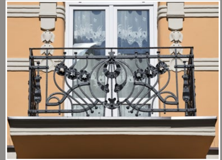
57 Balkon w kamienicy przy ul. Franciszkańskiej 13
