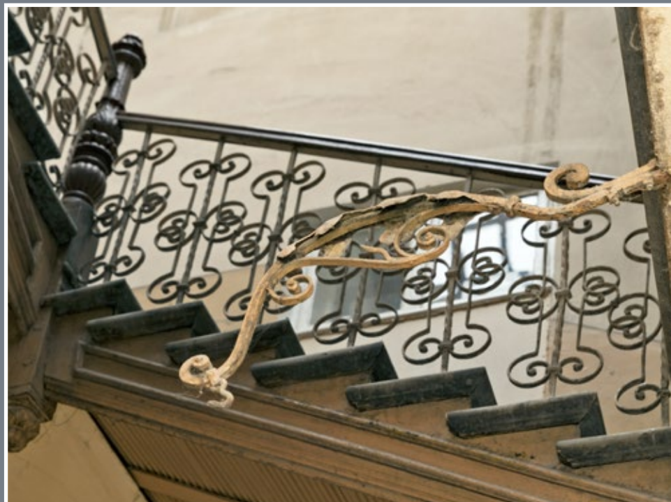
5 Balustrada schodów w kamienicy przy ul. Kazimierza Wielkiego 2/ Rynek 8 z drewnianym słupkiem i późniejszym uzupełnieniem przęsłami metalowymi; na pierwszym planie uchwyt na lampę oświetlającą schody
