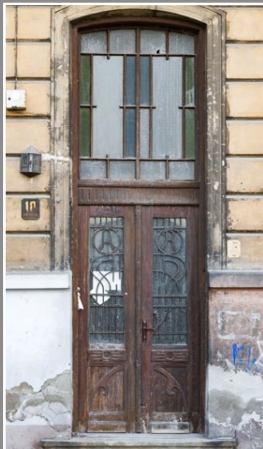
42 Drzwi w kamienicy przy ul. Łukasieńskiego 10 z wysokim naświetlem z zachowanym ornamentowym oszkleniem, z kratą prześwitów z literami „AR” upamiętniającymi właściciela Abrahama Rebhuna
