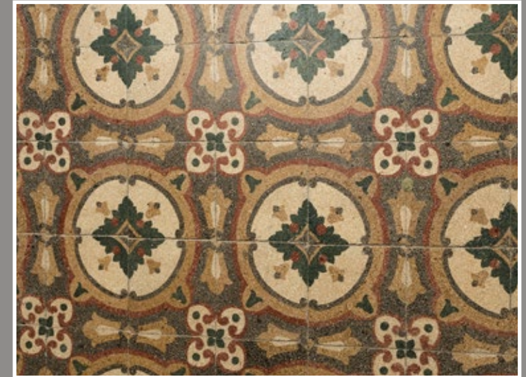
3 Posadzka w holu klatki schodowej na parterze w kamienicy przy ul. Dworskiego 23
