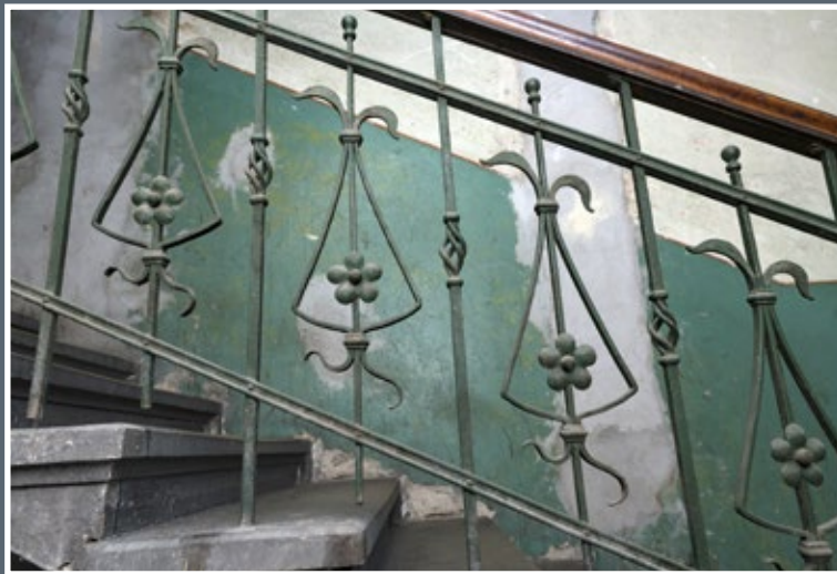
45 Balustrada schodów w kamienicy przy ul. Moniuszki 1/ Tarnawskiego 7
