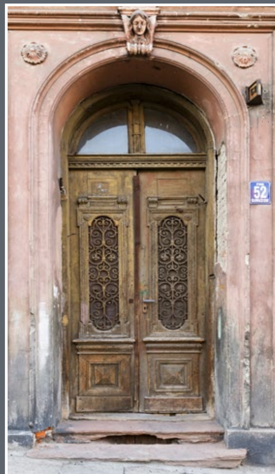
30 Drzwi w kamienicy przy ul. Słowackiego 52
