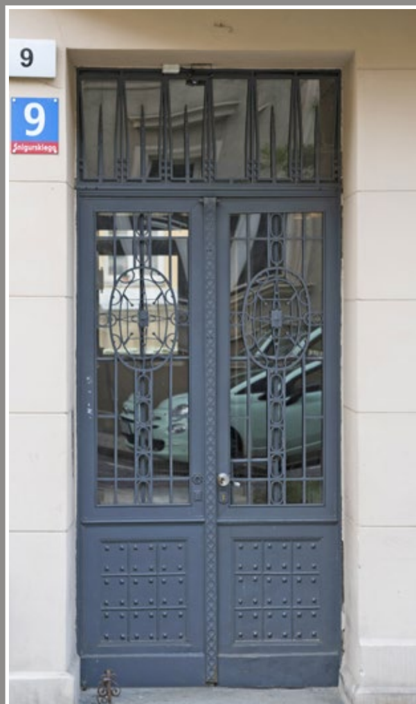
90 Metalowe drzwi w kamienicy przy ul. Śniwskiego 9
