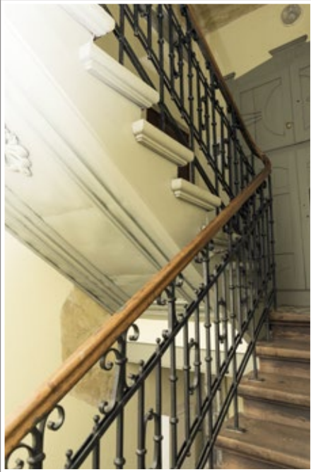
48 Balustrada schodów w kamienicy przy ul. Frankowskiego 2
