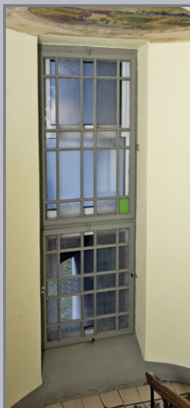
46 Okno klatki schodowej w kamienicy przy ul. Frankowskiego 2
