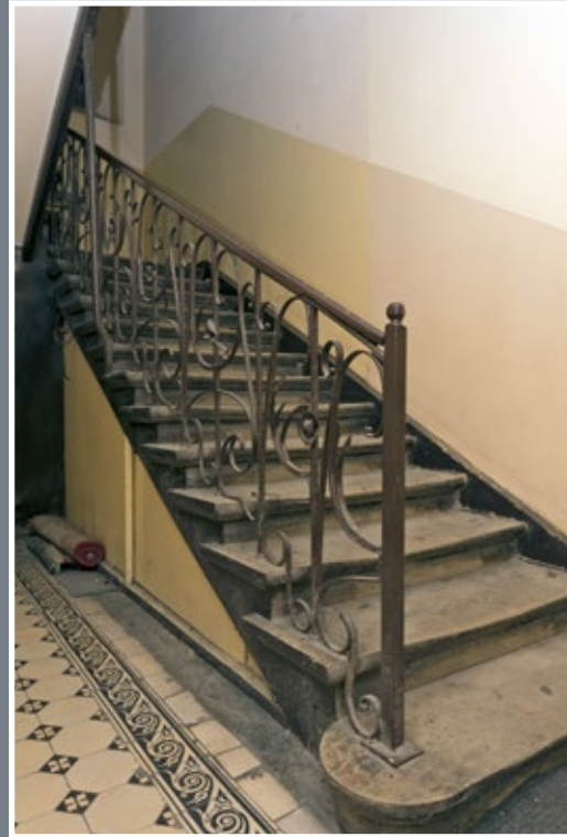
13 Balustrada schodów w kamienicy przy ul. Puszkina 3
