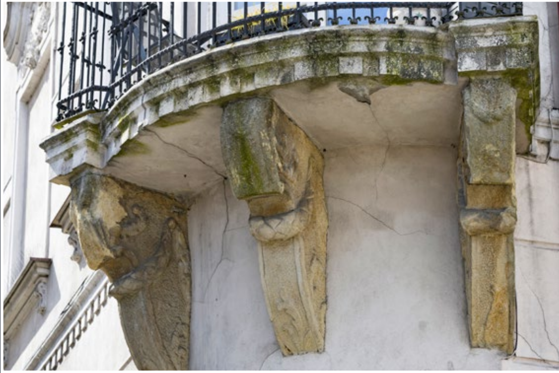
1 Balkon w kamienicy przy ul. Grodzkiej I z barokowymi, kamiennymi wspornikami o rzeźbiarskim opracowaniu
