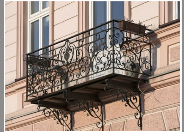
54 Balkon w kamienicy przy ul. Sienkiewicza 19
