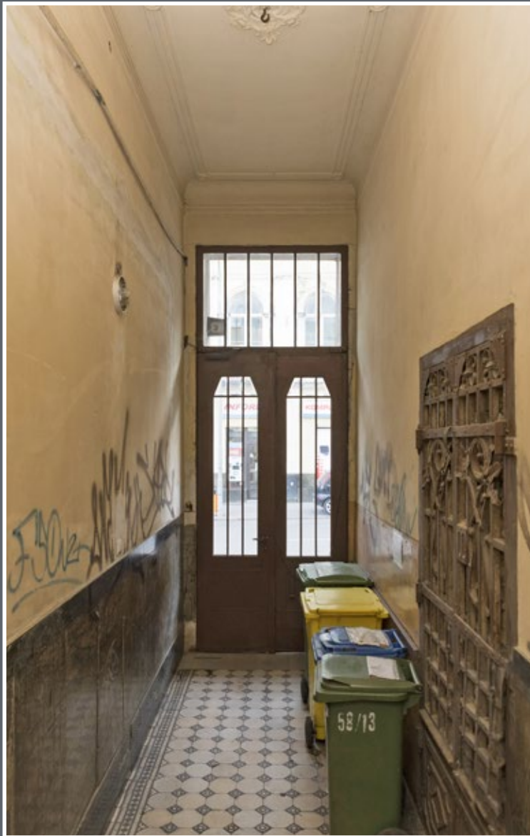
15 Sień w kamienicy przy ul. Mickiewicza 3 z zachowaną stiukową lamperią i dekoracją sufitu
