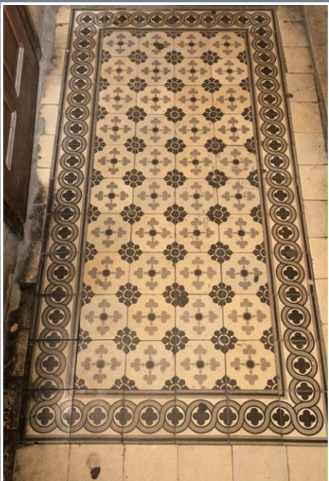
41 Posadzka w sieni kamienicy przy ul. Kazimierza Wielkiego 15
