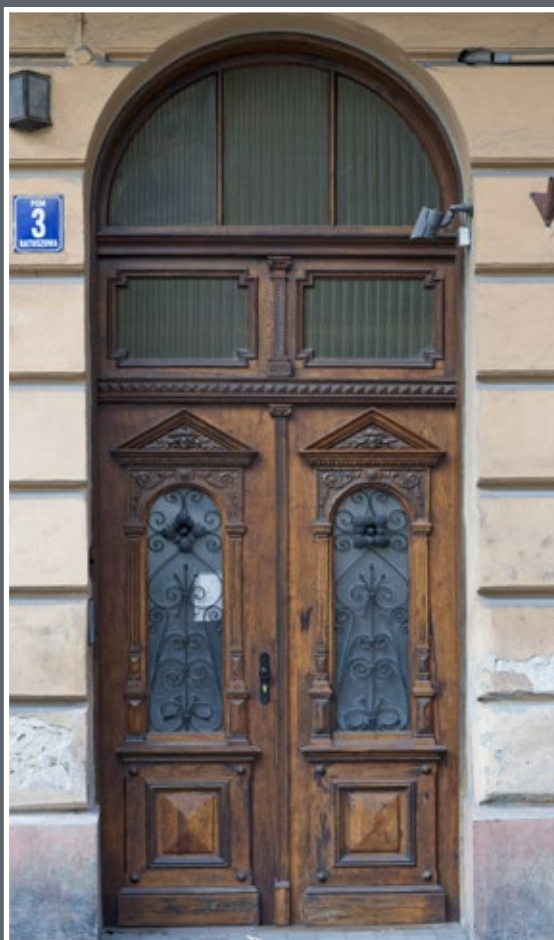
28 Drzwi w kamienicy przy ul. Ratuszowej 3
