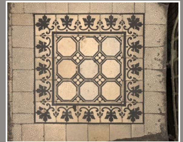
20 Posadzka na spoczniku klatki schodowej w kamienicy przy ul. Mickiewicza 1/Sowińskiego 2
