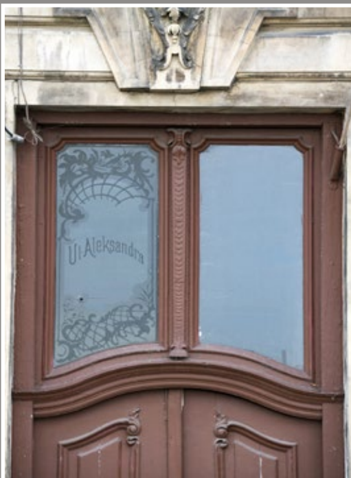
69 Nadświetle drzwi w kamienicy przy ul. Dworskiego 40 ze szkła trawionego z adresem: „ul. Aleksandra Dworskiego l. 42”. Na szybie prawej, zdemontowanej, widniała nazwa wykonawcy: „Birbach, Lwów – Sykstusa 23”
