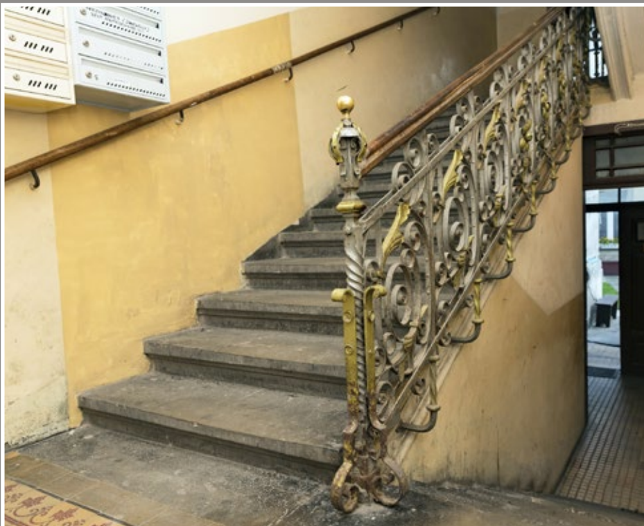
21 Schody w kamienicy inż. Juliusza Reinigera przy ul. Dworskiego 40 z ozdobnym słupkiem z mosiężną gałką na początku biegu i segmentami kutej balustrady ozdobionej kwiatami
