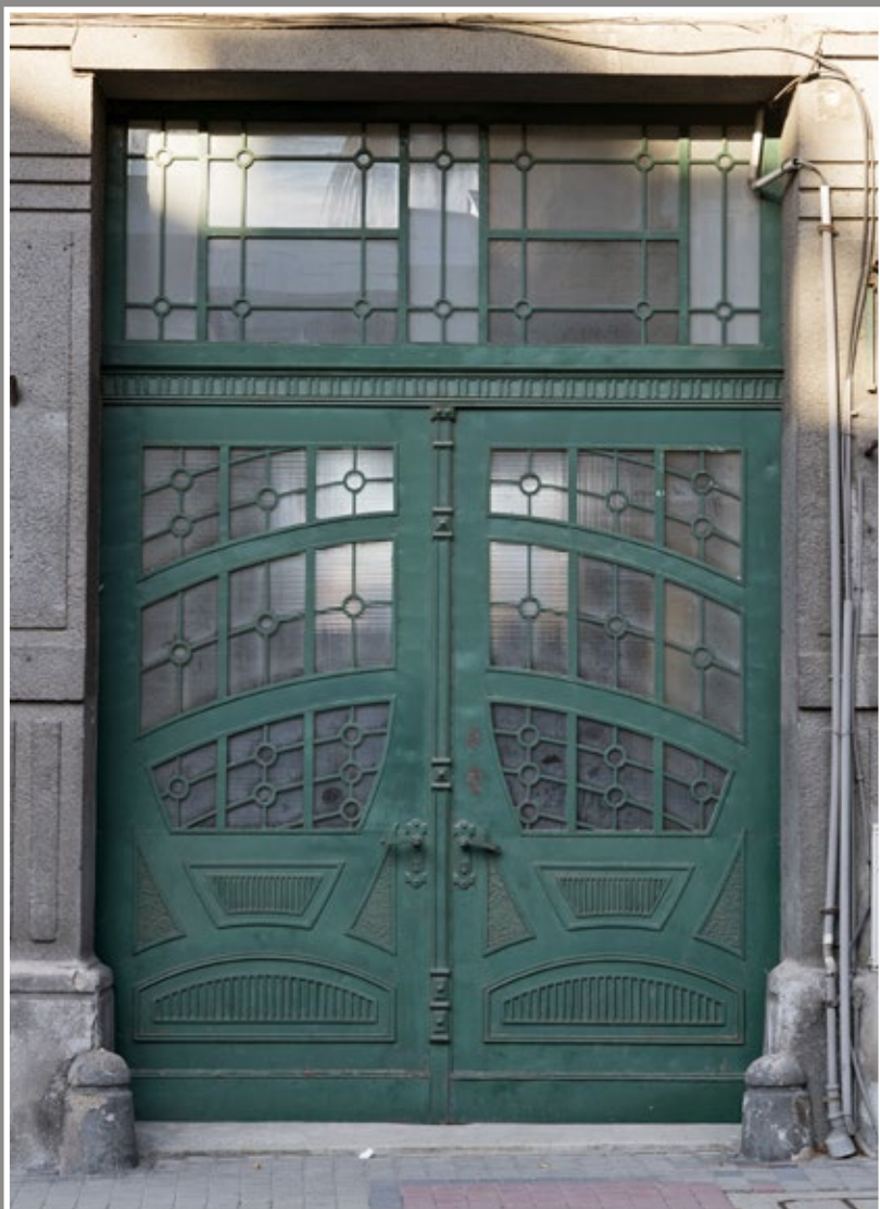
89 Żelazne wrota w kamienicy przy ul. Słowackiego 13 z zachowanymi klamkami; przed wrotami betonowe odbojniki
