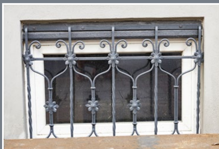
141 Krata okna piwnicznego w kamienicy przy ul. Słowackiego 6 I
