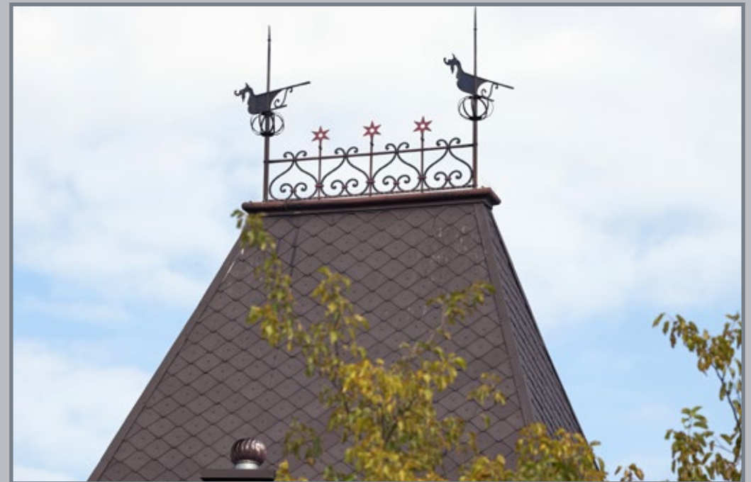
122 Kuta balustrada wieńcząca wieżyczkę willi „Elżbieta”, z małymi blaszanymi smokami
