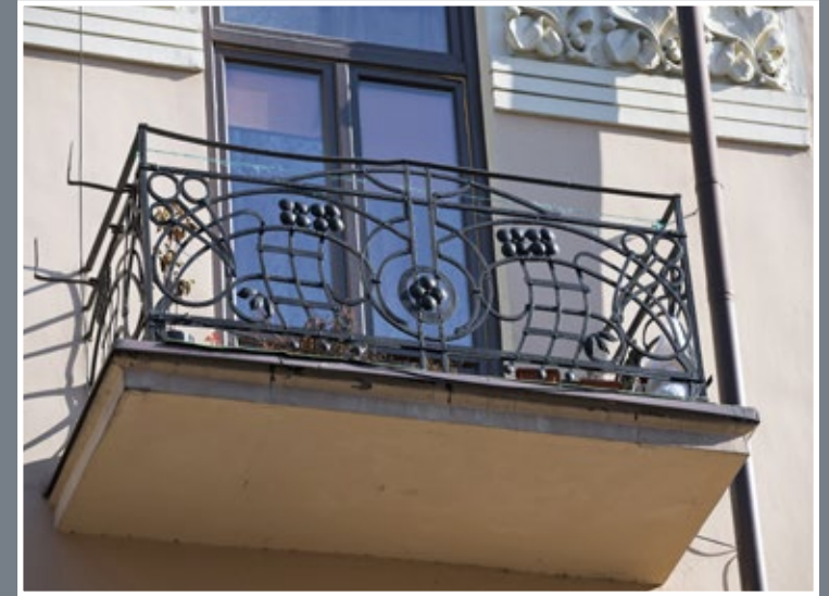
60 Balkon w kamienicy przy ul. Kazimierza Wielkiego 17
