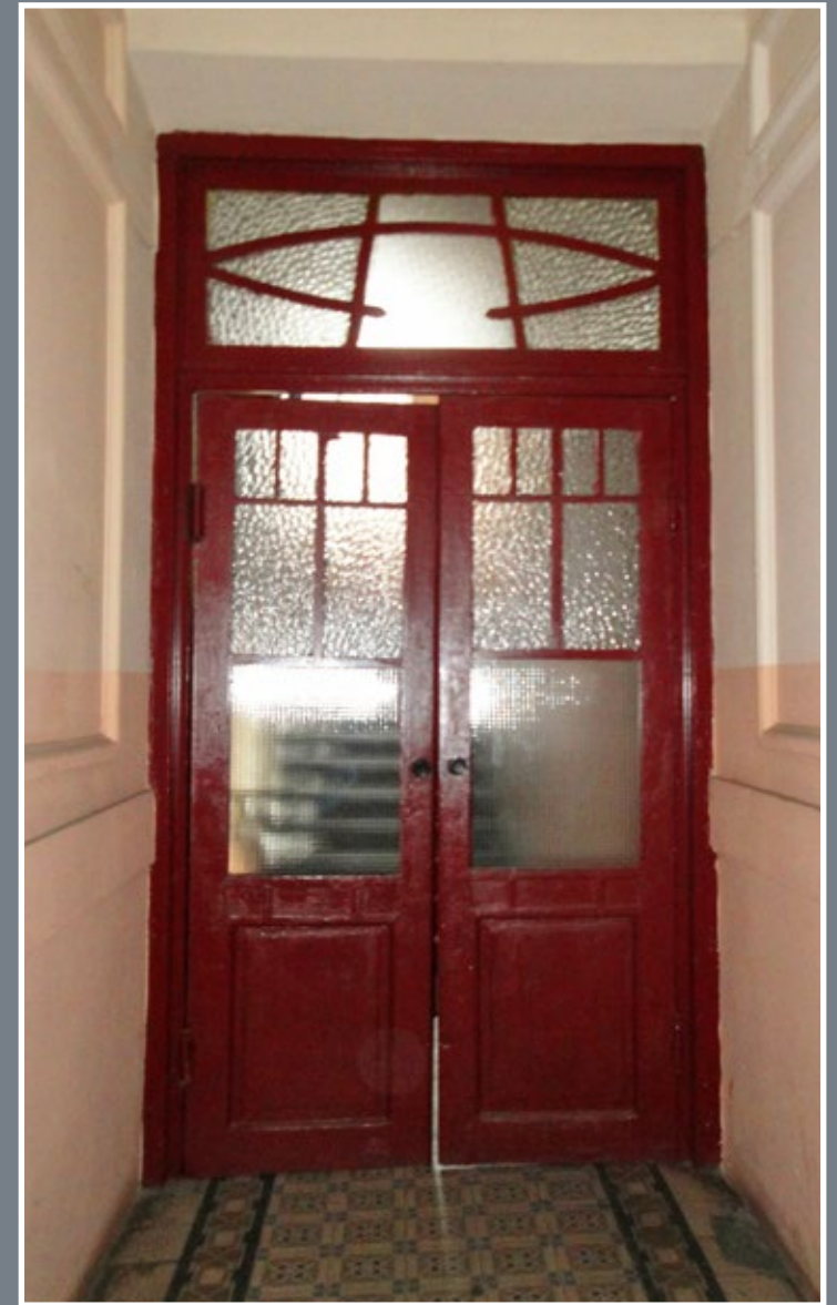
13 Drzwi z sieni do klatki schodowej w kamienicy przy ul. Słowackiego 63
