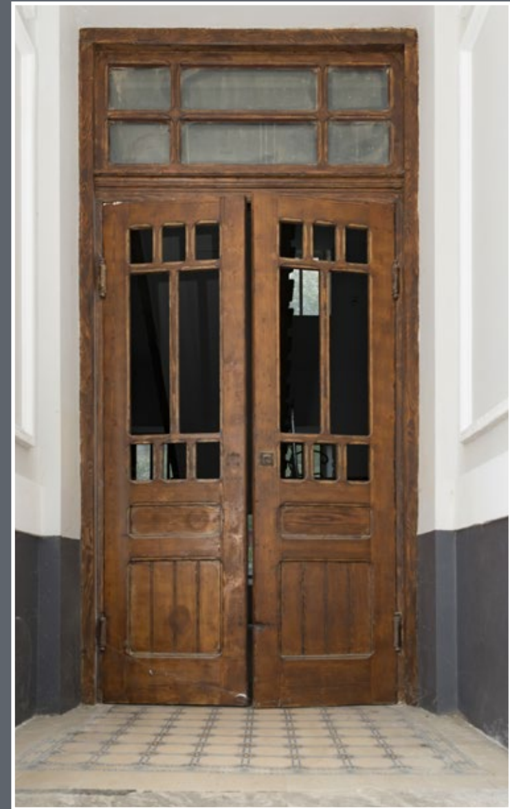
16 Drzwi z sieni do klatki schodowej w kamienicy przy ul. Łukasińskiego 10
