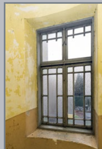
47 Okno klatki schodowej w kamienicy przy ul. Długosza 4
