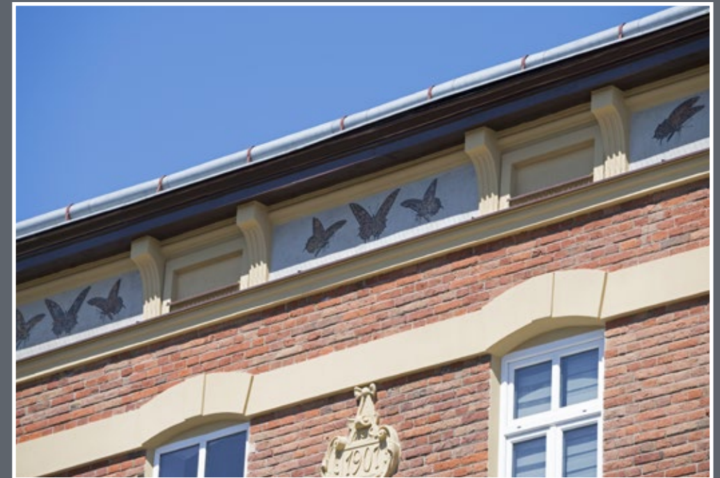
70 Fryz z malowanych motyli na budynku przy ul. Barskiej 8
