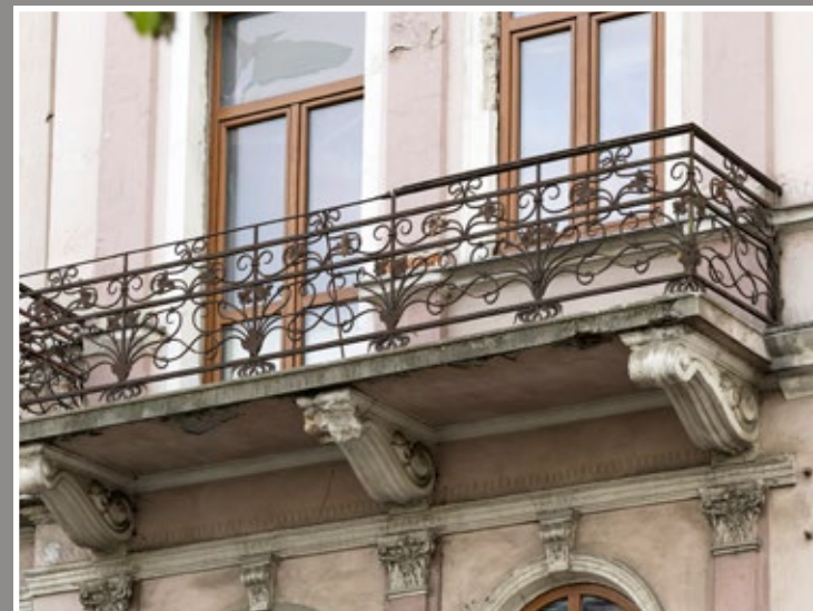
41 Balkon I piętra kamienicy przy ul. 3 Maja 29–33 o powtarzalnej dekoracji w formie kwiatowych bukietów
