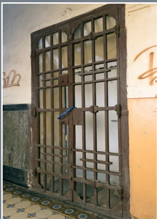
97 Żelazna krata w tylnej sieni kamienicy przy ul. Mickiewicza 3
