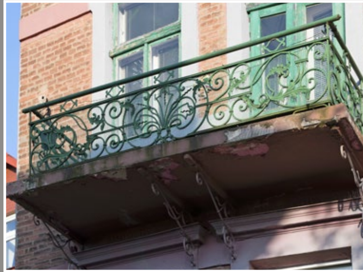
53 Balkon II piętra kamienicy przy ul. Sienkiewicza 11
