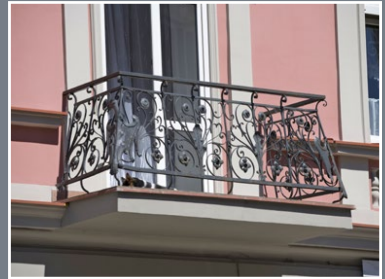
25 Balkon w kamienicy przy ul. Grunwaldzkiej 28 z przedstawieniem płaskich ortów w narożach
