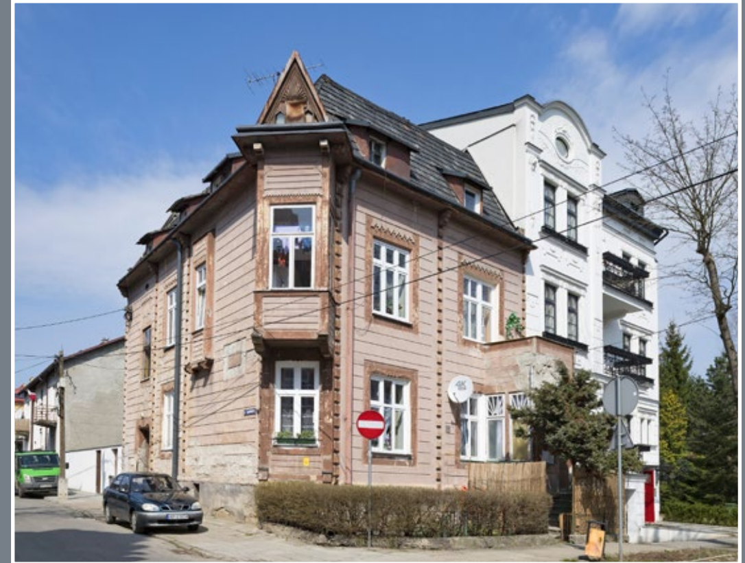
41 Budynek przy ul. Kasprowicza 15 z początku XX wieku o nietypowym opracowaniu tynkowych elewacji imitujących drewniane belki i deski, z detalem o wrytym w tynku ornamentie
