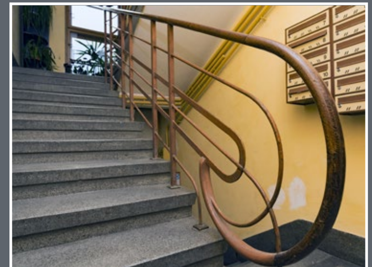
58 Balustrada schodów w kamienicy przy ul. Dworskiego 17
