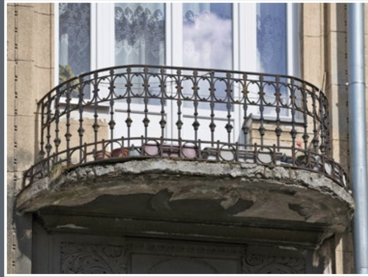
70 Balkon w kamienicy przy ul. Franciszkańskiej 35
