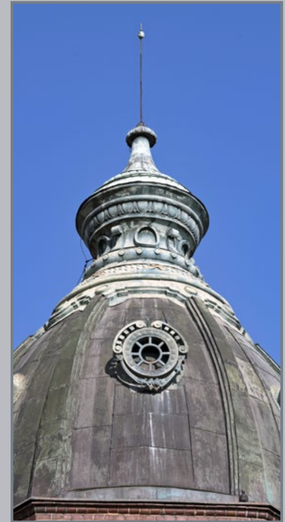
118 Opracowanie kopuły Domu Narodowego przy ul. Kościuszki 5
