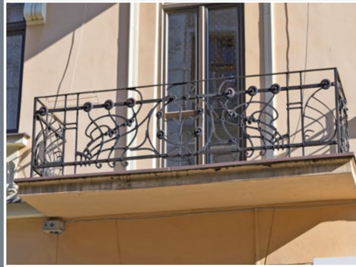
59 Balkon w kamienicy przy ul. Kazimierza Wielkiego 17
