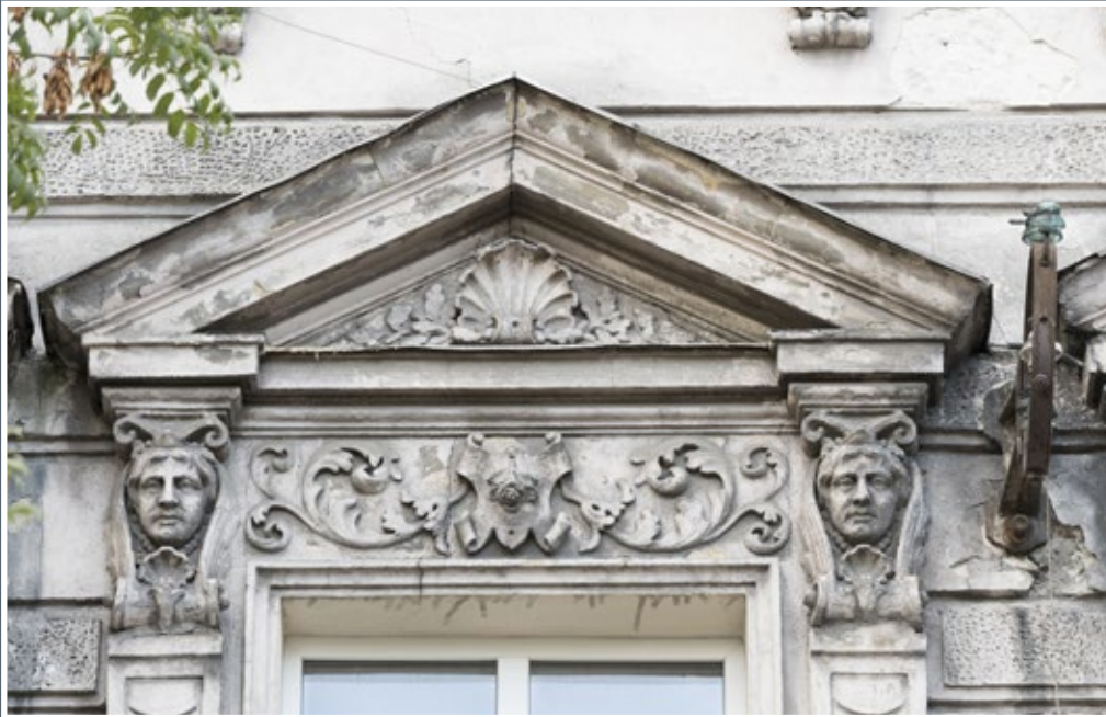
9 Dekoracja naczółka okna I piętra w kamienicy przy ul. Czarnieckiego 3 – o roślinnym charakterze, z głowami kobiecymi jako kapitelami pilastrów
