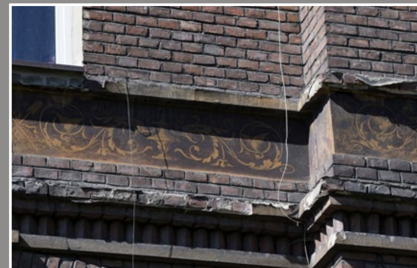
73 Sgraffitowy fryz pomiędzy piętrami willi przy ul. Okrzei 18
