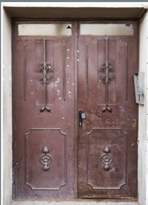
80 Żelazne drzwi do kamienicy przy Placu na Bramie 10, prawdopodobnie z lat 60. lub 70. XIX wieku, z charakterystycznym dla drzwi klasycystycznych wąskim nadświetlem, ze skromną dekoracją z repusowanych w blaszce kwiatków i listków
