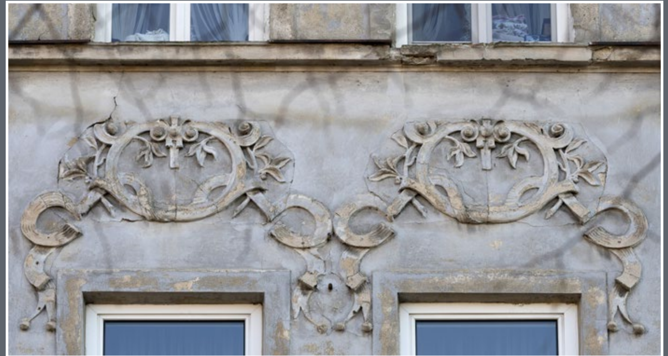
61 Dekoracja nad oknami budynku przy ul. Barskiej 12
