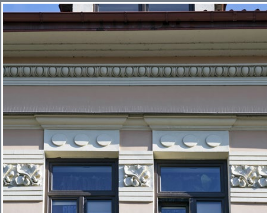
36 Secesyjny wystrój kamienicy przy ul. Kazimierza Wielkiego 17
