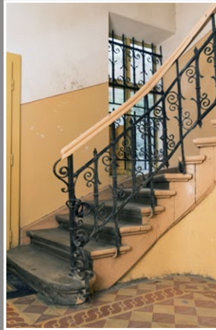
49 Balustrada schodów w kamienicy przy ul. Kmity 5
