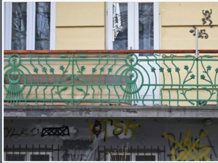
65 Balkon w kamienicy przy ul. Barskiej 4
