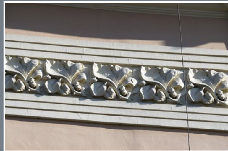
40 Fryz z liści kasztanowca na elewacji kamienicy przy ul. Kazimierza Wielkiego 17
