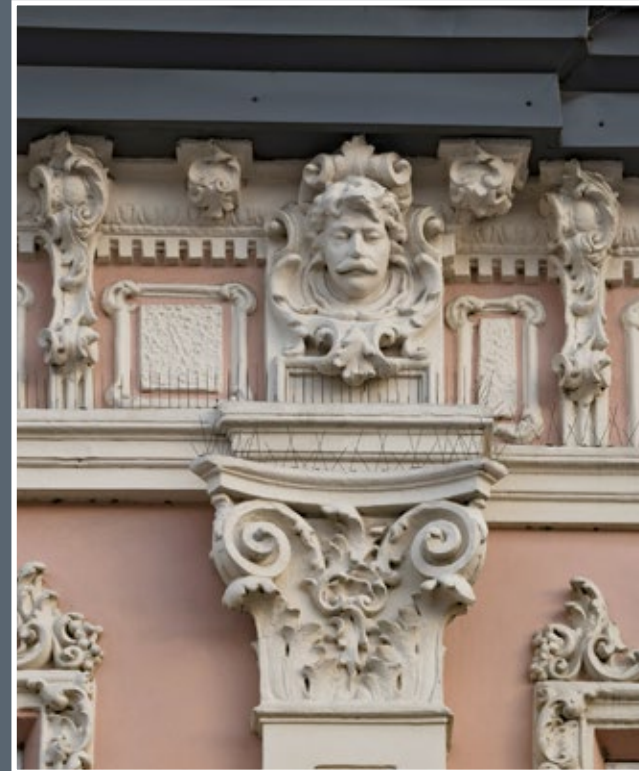
8 Wystrój elewacji kamienicy przy ul. Grunwaldzkiej 19 z detalem o neorokokowym charakterze z wykorzystaniem motywu głowy męskiej i puttów
