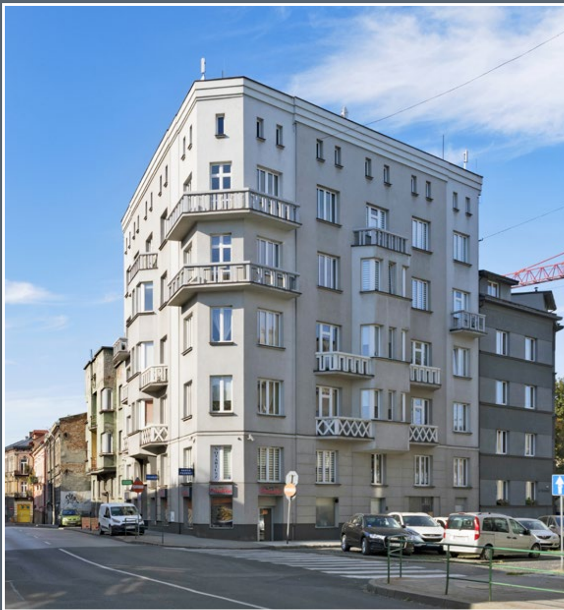
84 Kamienica przy ul. Dworskiego 19 z początku lat 30. XX wieku
