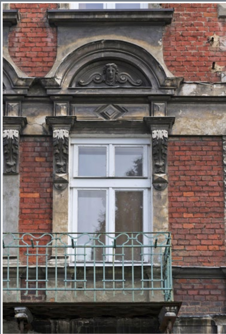
18 Detale wystroju elewacji kamienicy Leona Aszkenazego przy ul. Puszkina 3 z 1891 roku
