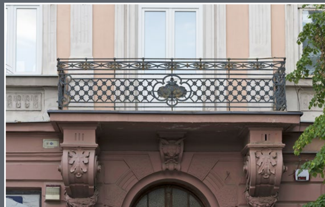
12 Balkon nad portalem wejściowym w kamienicy przy ul. 3 Maja 14; odlewane w żeliwie, ozdobione festonami wspomniki stanowią jednocześnie oprawę portalu drzwiowego
