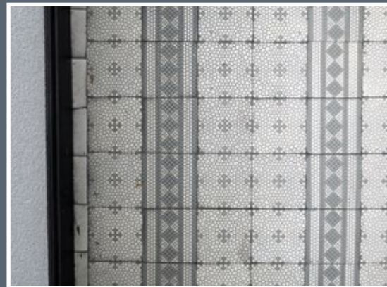
49 Posadzka w sieni kamienicy przy ul. Franciszkańskiej 1
