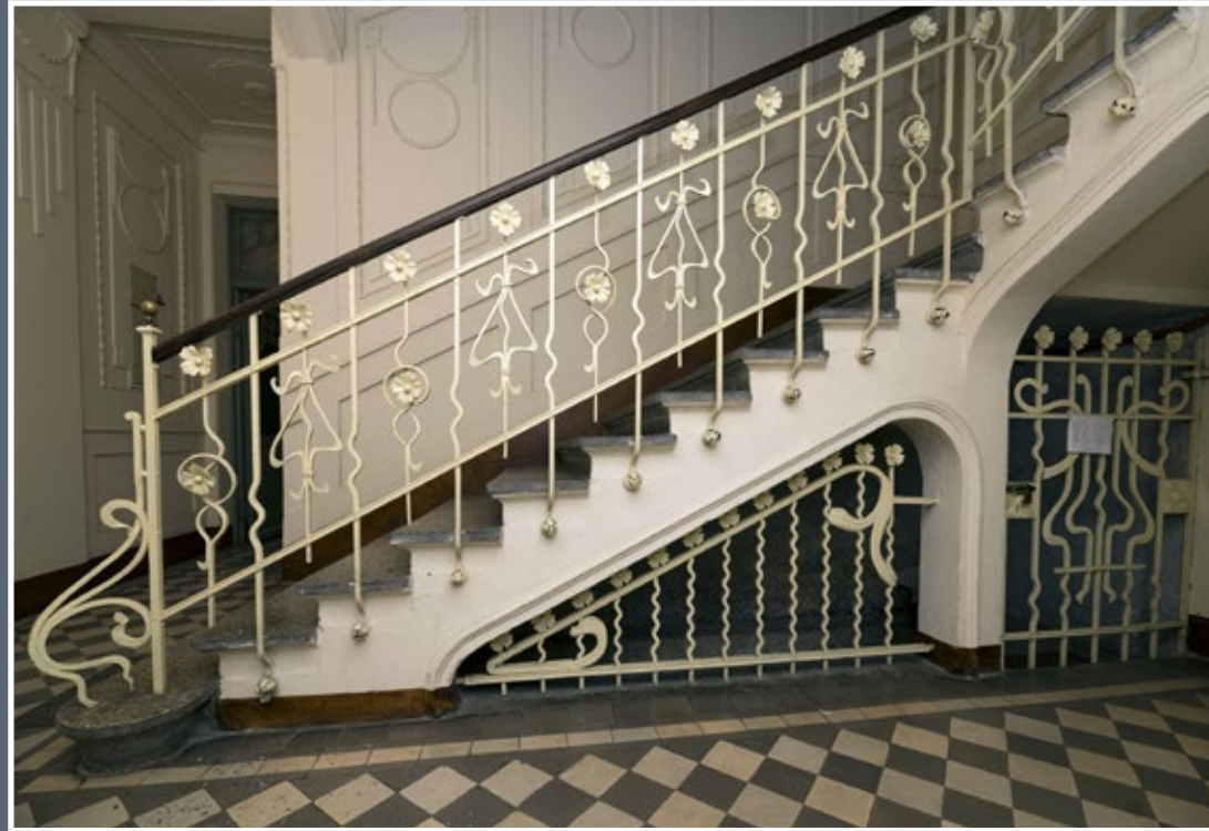
43 Balustrada schodów oraz krata przy wejściu do piwnicy w kamienicy przy ul. Puszkina 8a
