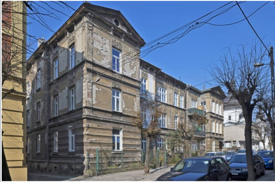
54 Budynek przy ul. Barskiej 4–6 projektu Marcellego Pileckiego powstałe przed 1910 rokiem
