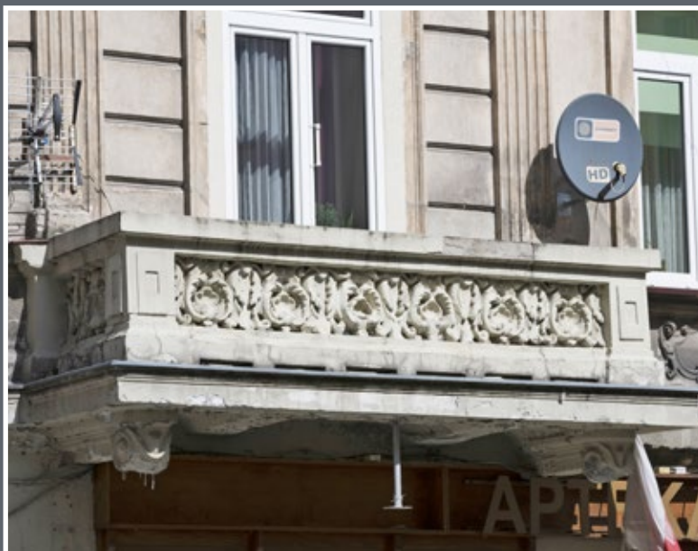
8 Balkon w kamienicy przy ul. Franciszkańskiej 5
