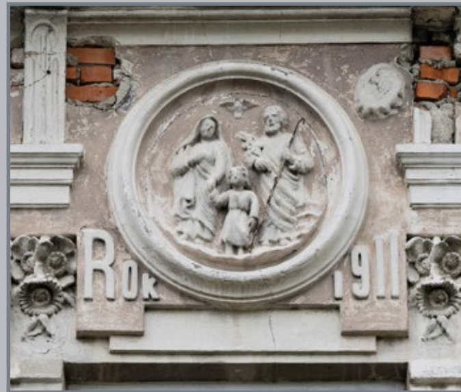
103 Płaskorzeźbiony wizerunek Świętej Rodziny umieszczony w zwieńczeniu naroża kamienicy przy ul. Raclawickiej 2
