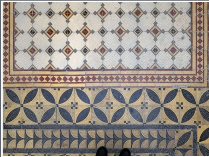
53 Posadzka na korytarzu piętra Domu Narodowego przy ul. Kościuszki 5
