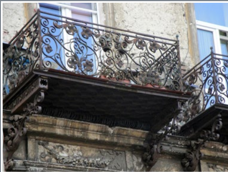
26 Balkony w kamienicy przy ul. Konarskiego 4
