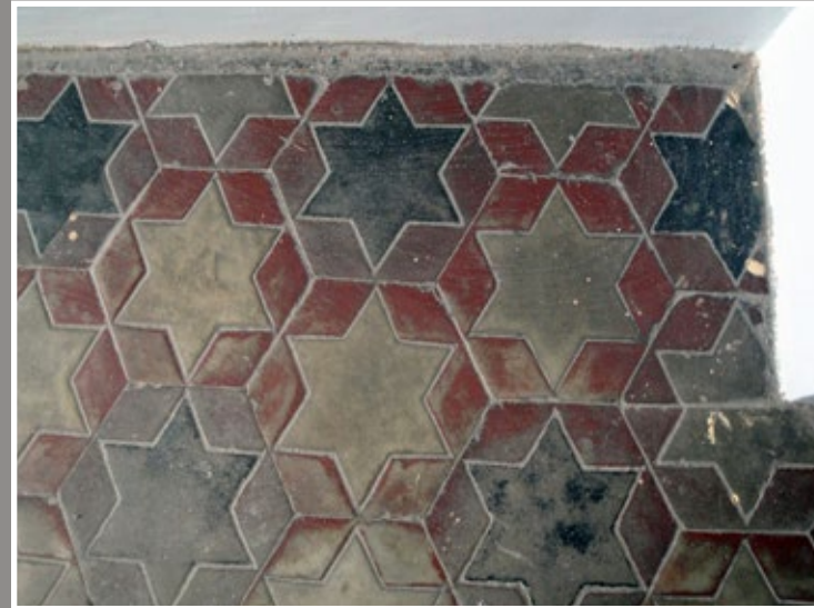
2 Skromna cementowa posadzka z wrytym motywem gwiazdy w sieni kamienicy przy ul. Mickiewicza 57
