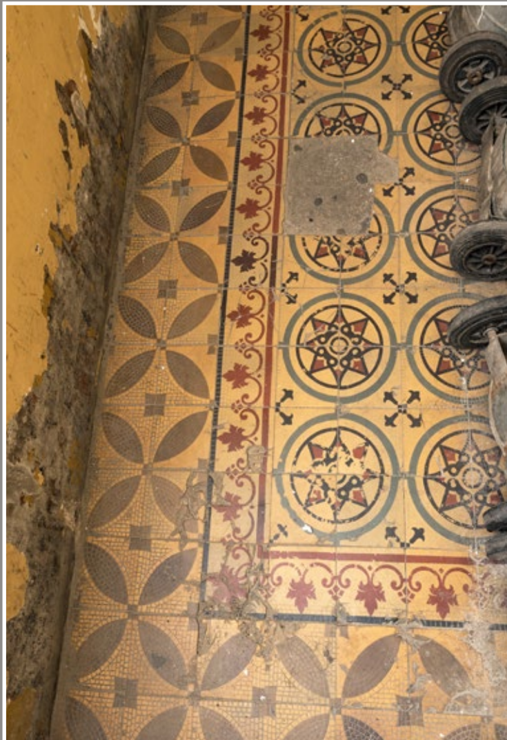
34 Posadzka w sieni kamienicy przy ul. Kazimierza Wielkiego 2/ Rynek 8
