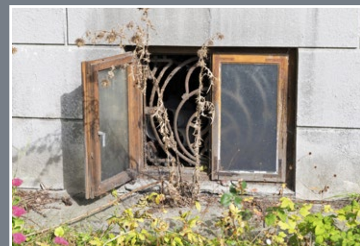
142 Krata okienka piwnicznego w willi przy ul. Puszkina 15
