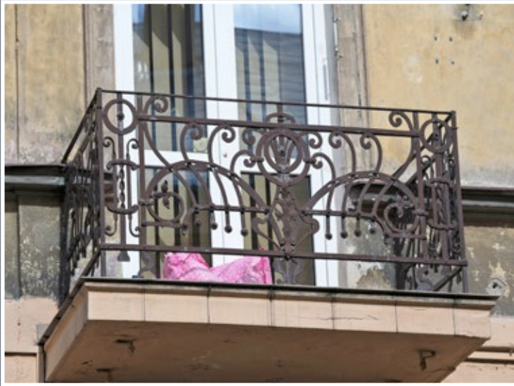
58 Balkon w kamienicy przy ul. Franciszkańskiej 17
