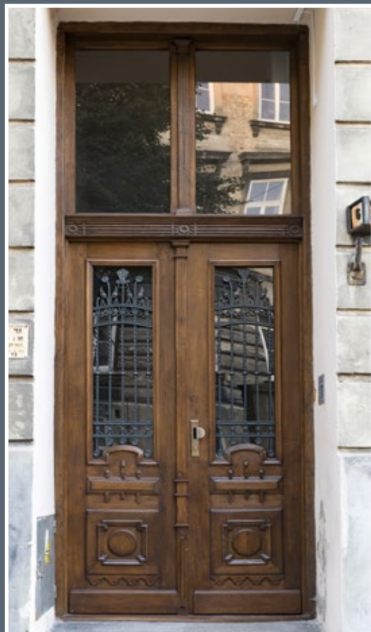
49 Drzwi w kamienicy przy ul. Rejtana 6
