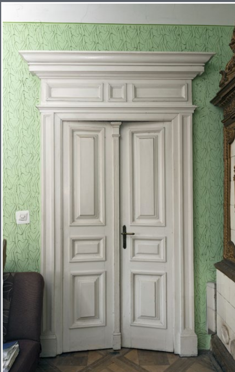
25 Drzwi w willi przy ul. św. Józefa 3 o tradycyjnym, klasycystycznym typie, z naczółkiem zwieńczonym gzymsem, profilowanymi płycinami skrzydeł, listwą przemykową w formie kanelowanego pilasterku, z zachowanym szyldem z klamką
