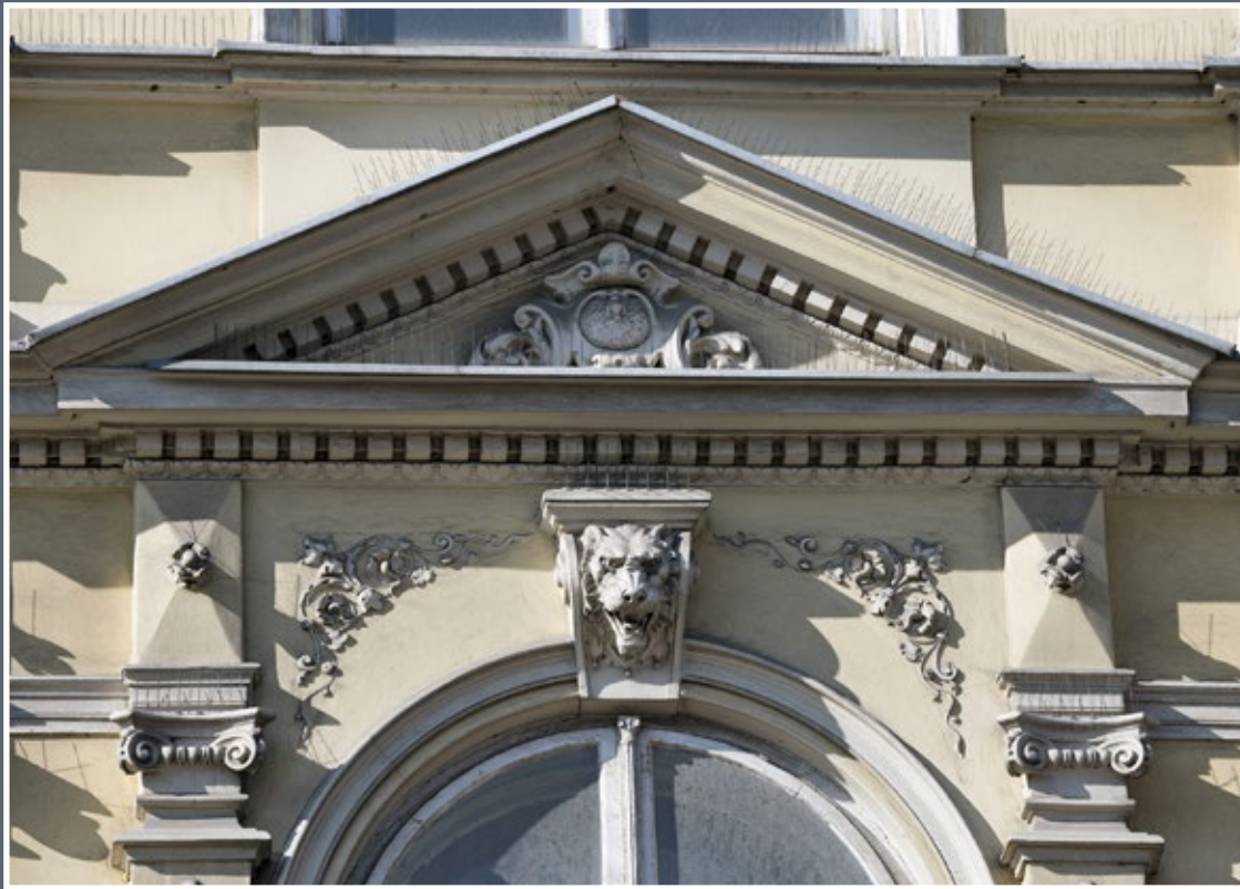
16 Oprawa okna I piętra wykusza w kamienicy przy ul. Jagiellońskiej 21, z głową lwa w kluczu, w otoczeniu roślinnego ornamentu
