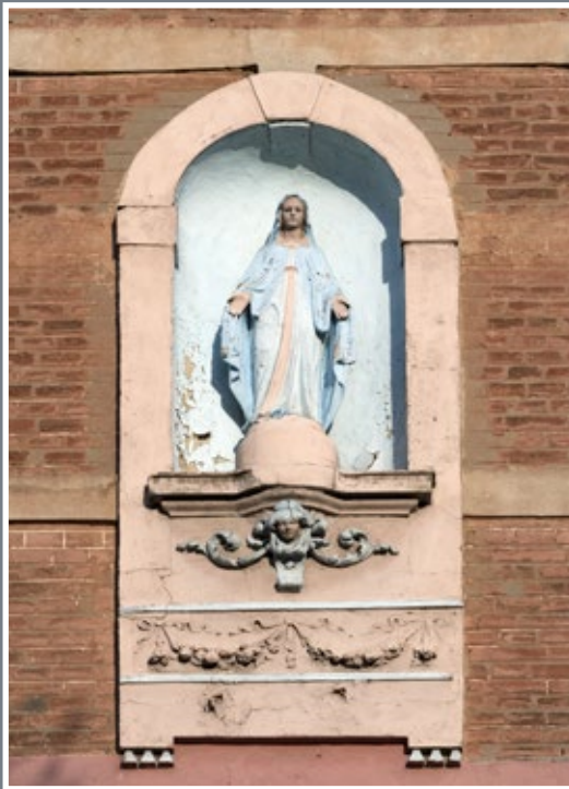
88 Rzeźba Matki Bożej we wnęcie fasady kamienicy przy ul. Sienkiewicza 11
