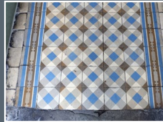
48 Posadzka w sieni kamienicy przy ul. Franciszkańskiej 15
