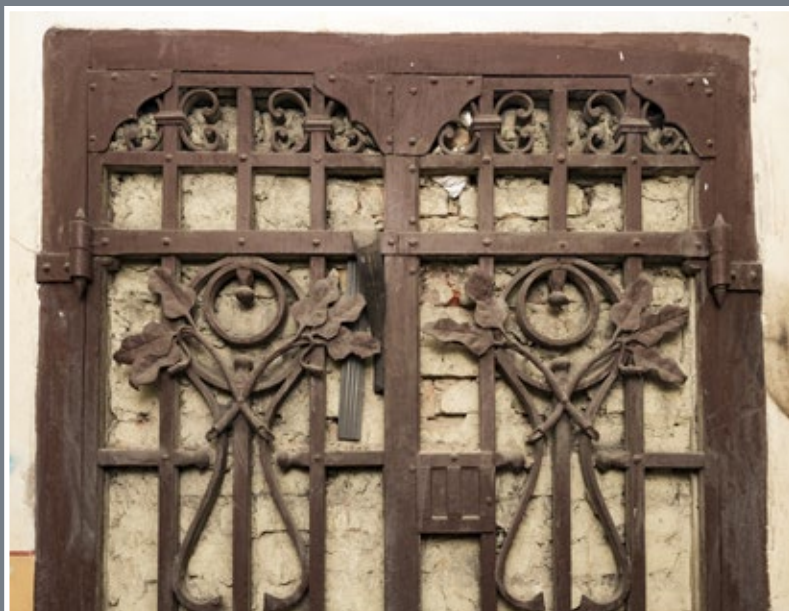
96 Żelazna krata w sieni kamienicy przy ul. Mickiewicza 3, zdobiona secesyjną dekoracją repusowanymi w blaszce liśćmi dębowymi
