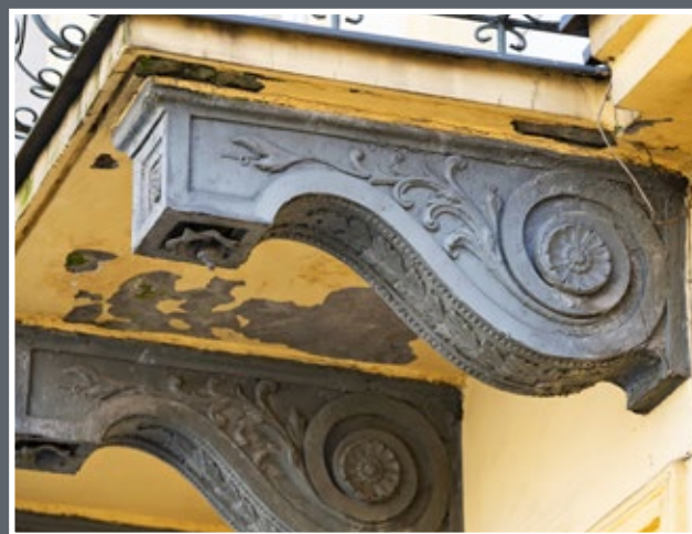
9 Żeliwne wspomniki balkonu hotelu „Viktoria” przy ul. Mickiewicza 18
