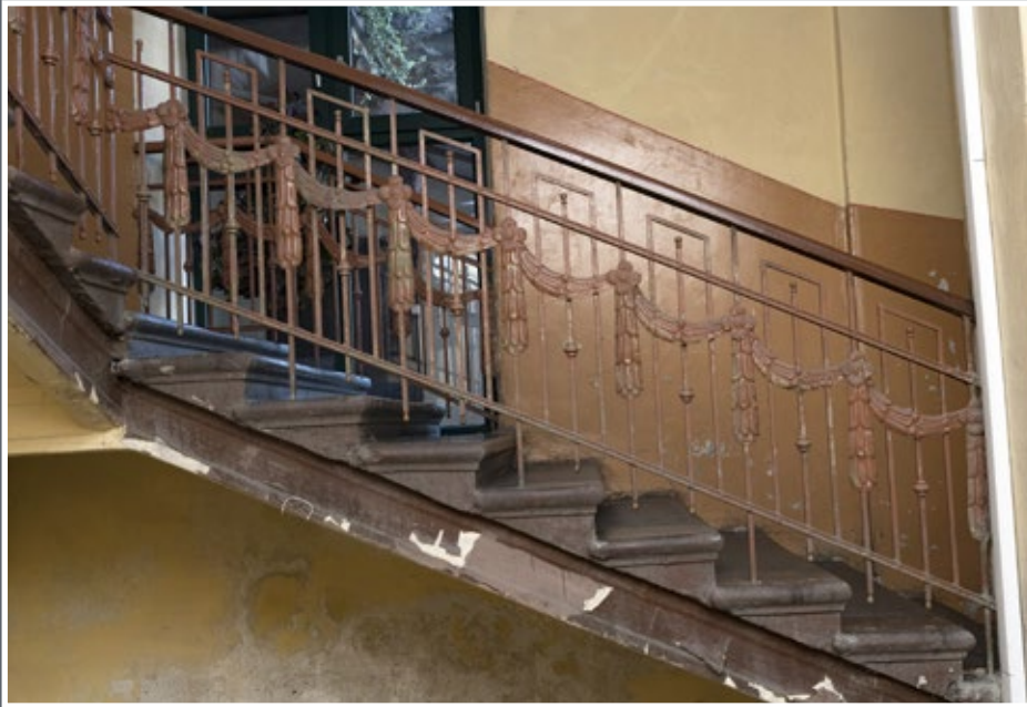
54 Balustrada schodów w kamienicy przy ul. Słowackiego 13
