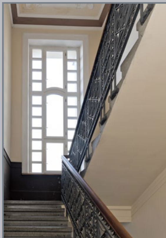
44 Okno oświetlające klatkę schodową w kamienicy przy ul. Słowackiego 6 I
