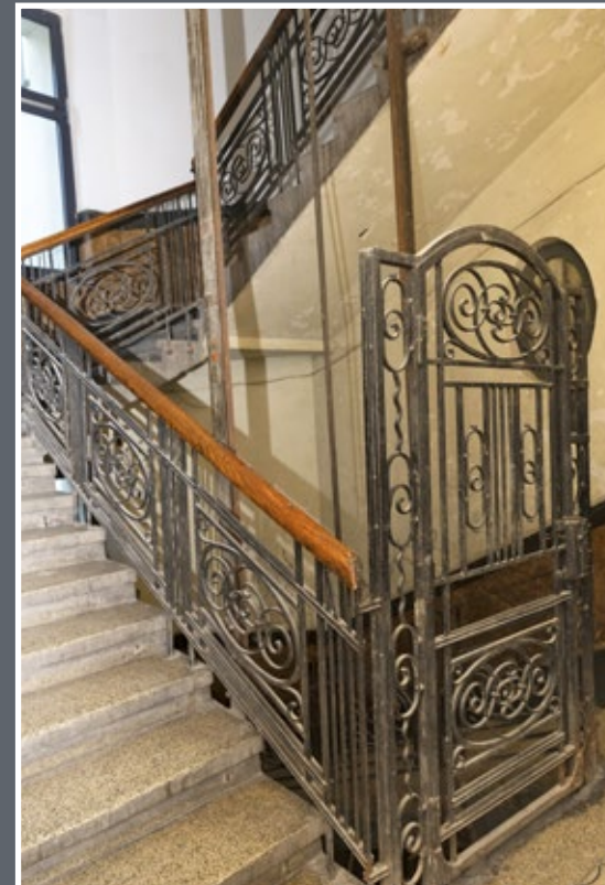
26 Balustrada schodów w kamienicy przy ul. Dworskiego 23
