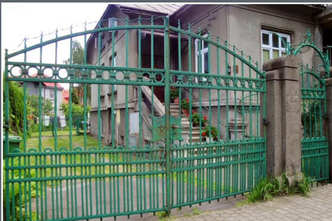
146 Brama wjazdowa z bramką na posesję przy ul. Kilińskiego 13; szyld zamku bramki z sygnaturą wykonawcy: „WŁ. WOJNAR PRZEMYŚL”
