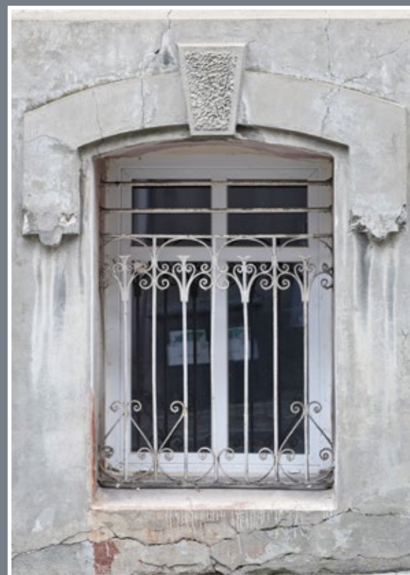
138 Krata okna piwnicznego w kamienicy przy ul. Waygarta 1
