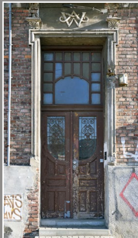
43 Drzwi w kamienicy przy ul. Niemcewicza 2 z częściowo zachowanym przeszkleniem z kolorowego szkła w nadświetlu, z monogramem właściciela „AW” (Antoni Wnęć) w kracie prześwitów oraz nad drzwiami
