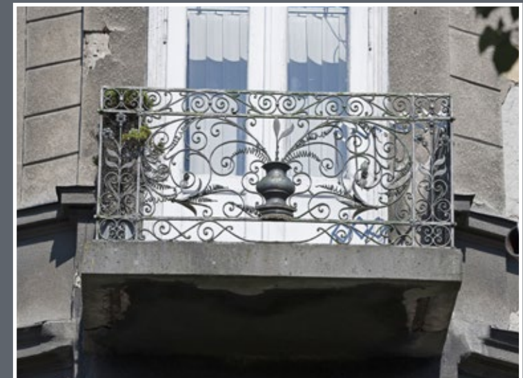
37 Balkon II piętra naroża kamienicy przy ul. 3 Maja 39 z wazonem jako centralnym elementem kompozycji balustrady
