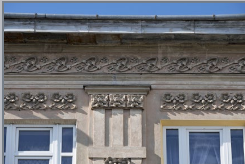
48 Detale wystroju elewacji kamienicy przy ul. Długosza 6: kwiatowe fryzy w zwieńczeniu, oprawa okien
