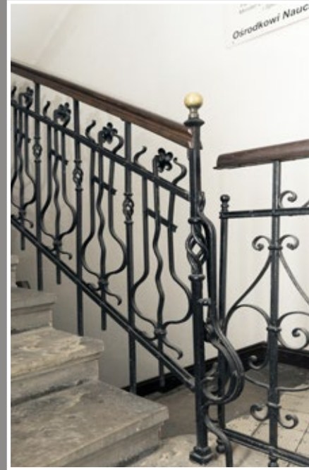
50 Balustrada schodów w kamienicy przy ul. Franciszkańskiej 3
