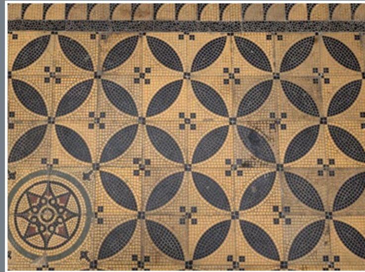
13 Posadzka w korytarzu piątra Domu Narodowego przy ul. Kościuszki 5, z prawdopodobnie wtórnym montażem płytek z gwiazdą
