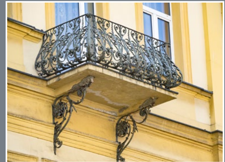
28 Balkon w budynku dawnego hotelu „Victoria” przy ul. Mickiewicza 18
