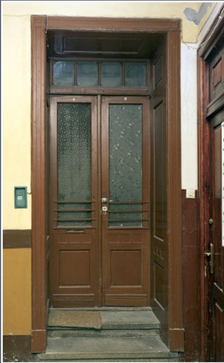
37 Drzwi do mieszkania w kamienicy przy ul. Śmigurskiego 9
