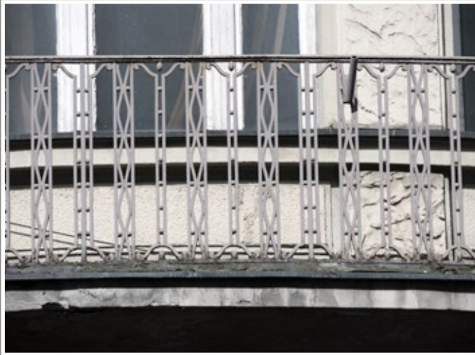
75 Balkon w kamienicy przy ul. Franciszkańskiej 37
