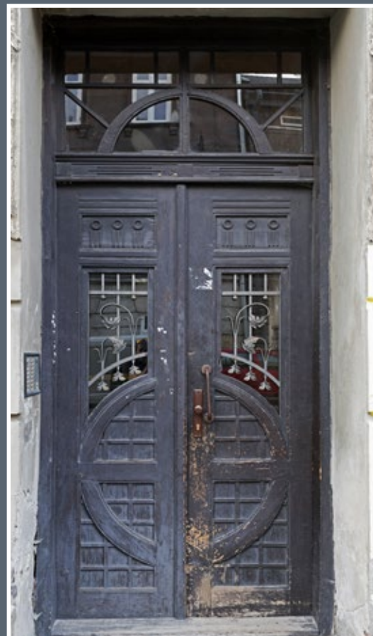
50 Drzwi w kamienicy przy ul. Słowackiego 63
