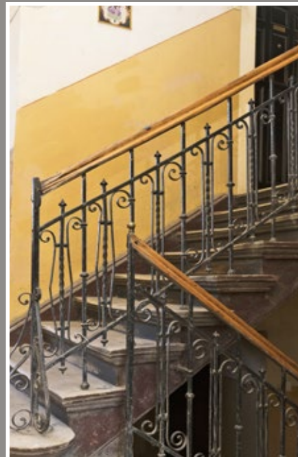
52 Uproszczona w formie balustrada schodów w kamienicy przy ul. Raławickiej 2
