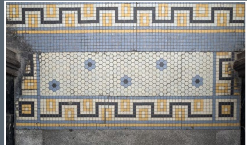
50 Posadzka klatki schodowej w kamienicy przy ul. Mickiewicza 3
