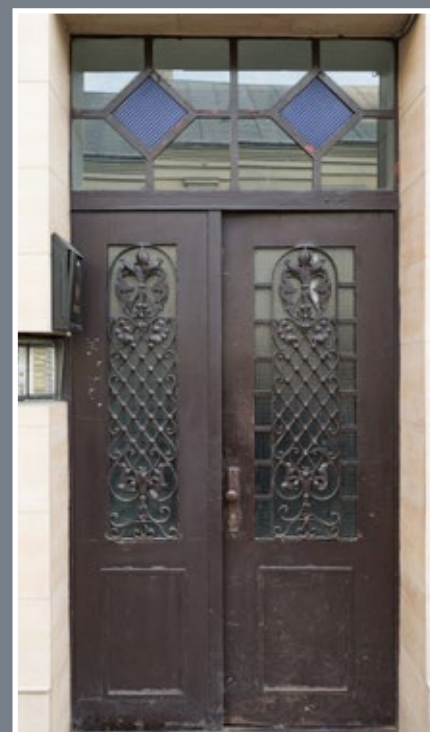
81 Żelazne drzwi do kamienicy przy ul. Słowackiego 2 z lat 90. XIX wieku o formie typowej dla drzwi drewnianych
