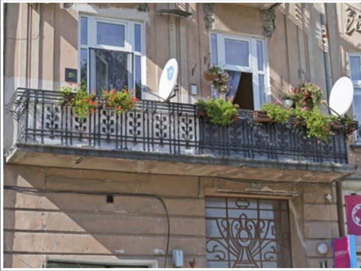
69 Balkon w kamienicy przy ul. Długosza 6
