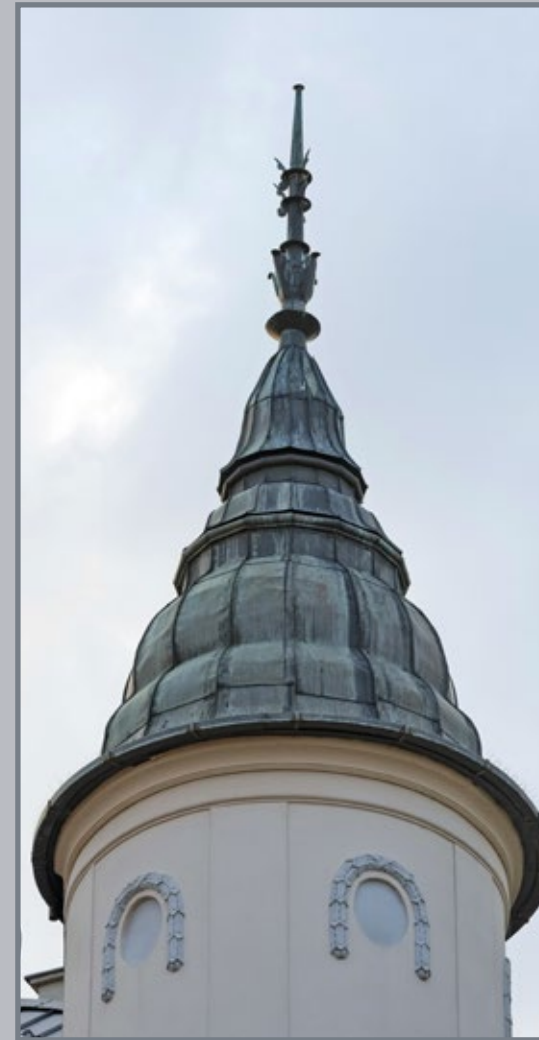
117 Helm z iglicą wieżyczki na kamienicy przy ul. Śmigurskiego 9
