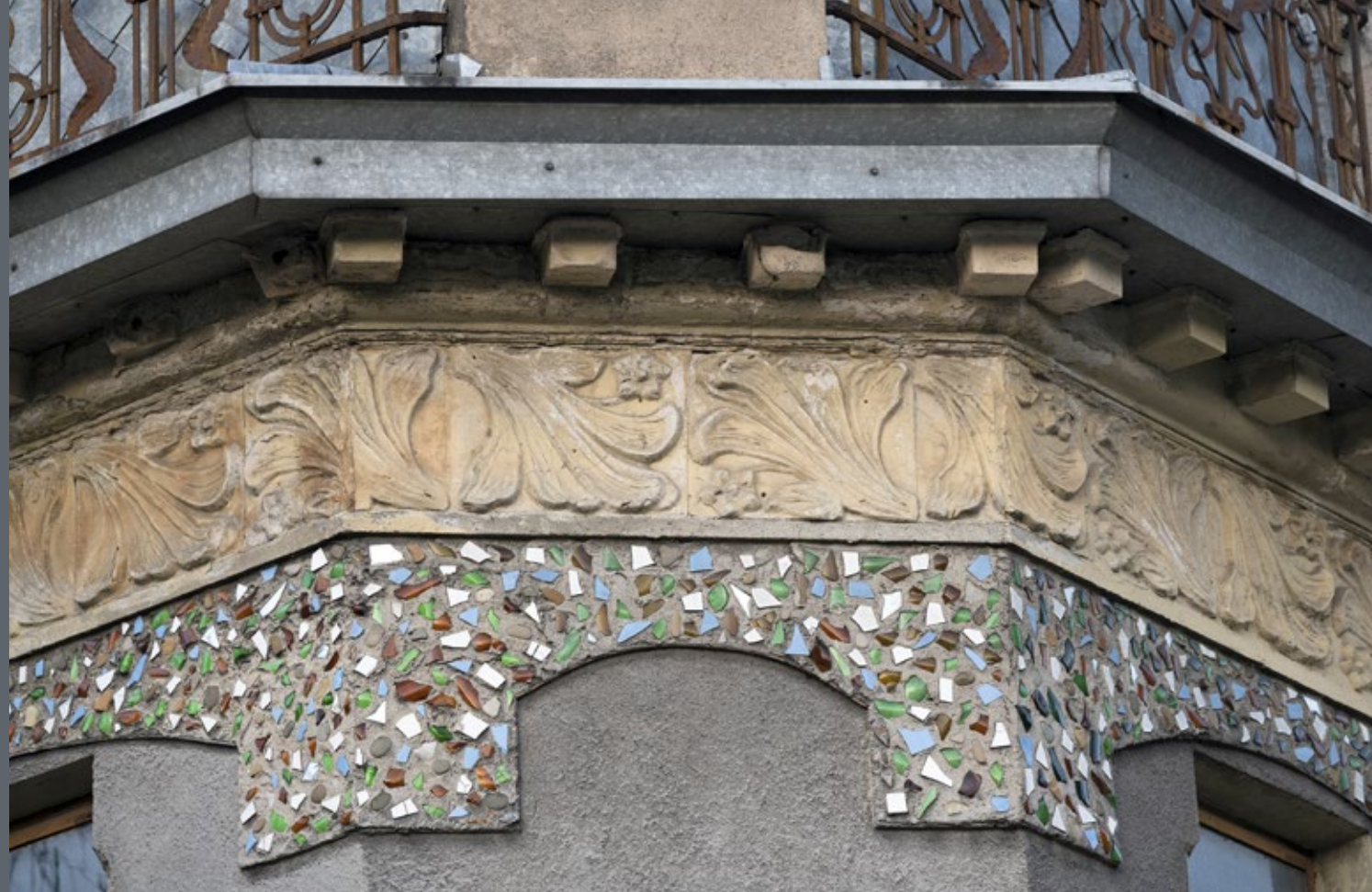
45 Zestawienie fryzu roślinnego z fryzmem z kamieni otoczaków w zwieńczeniu elewacji wieżyczki willi przy ul. Puszkina 15
