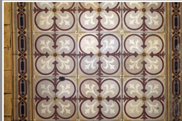
37 Posadzka w sieni kamienicy przy ul. Franciszkańskiej 19
