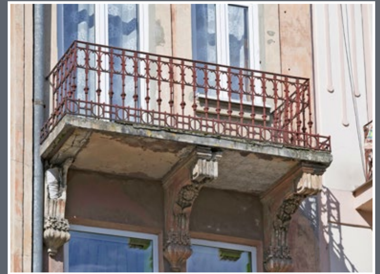
68 Balkon w kamienicy przy ul. Długosza 4
