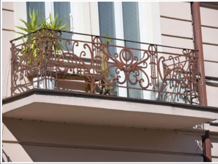
64 Balkon w kamienicy przy ul. Długosza 2
