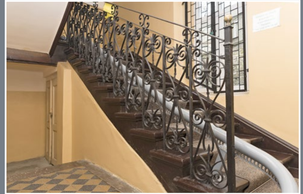
14 Balustrada schodów w kamienicy przy ul. Waygarta 1 z segmentami wolutowej dekoracji o formie klepsydry pomiędzy prętami konstrukcyjnymi
