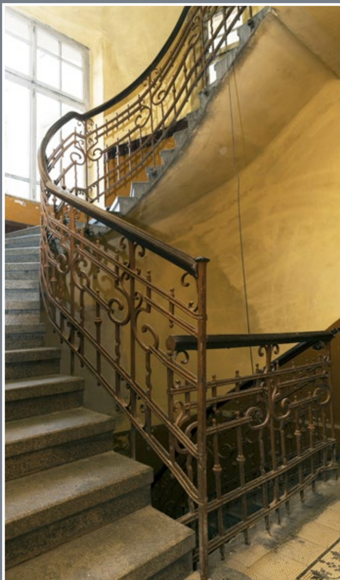
36 Balustrada schodów w kamienicy przy ul. Śnińskiego 9
