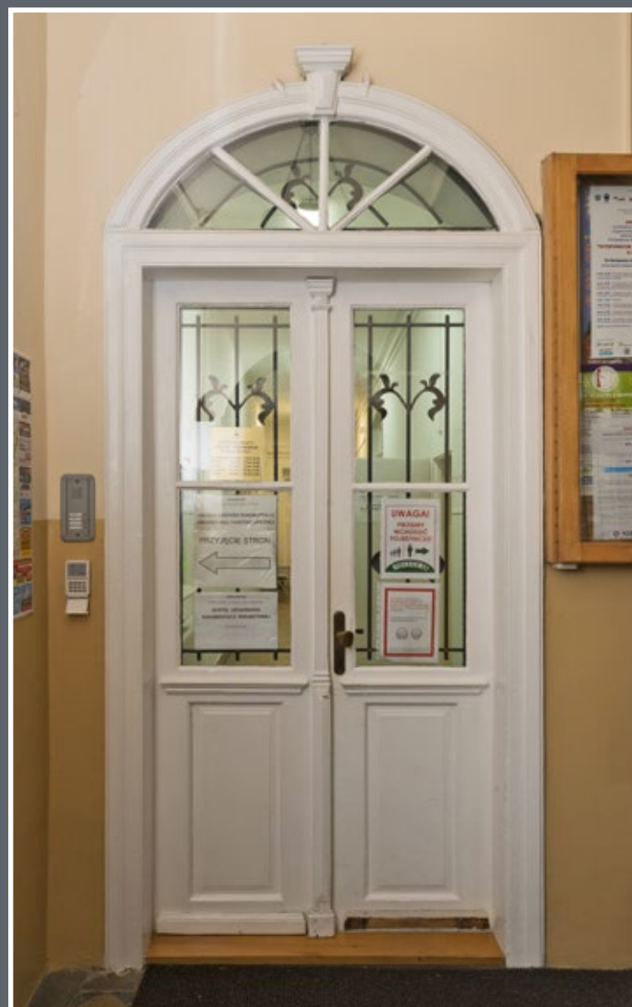
6 Drzwi wewnętrzne z sieni na korytarz w kamienicy przy ul. Waygarta 1
