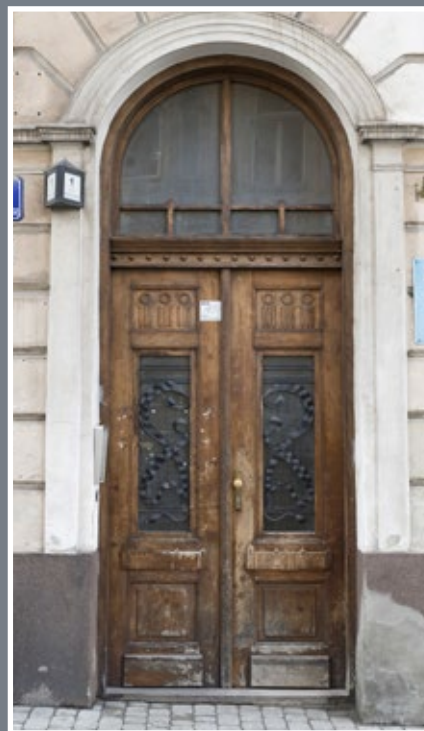
78 Drzwi w kamienicy przy ul. Sowińskiego 1 o interesującym opracowaniu krat prześwitów w formie wijącej się wstęgi
