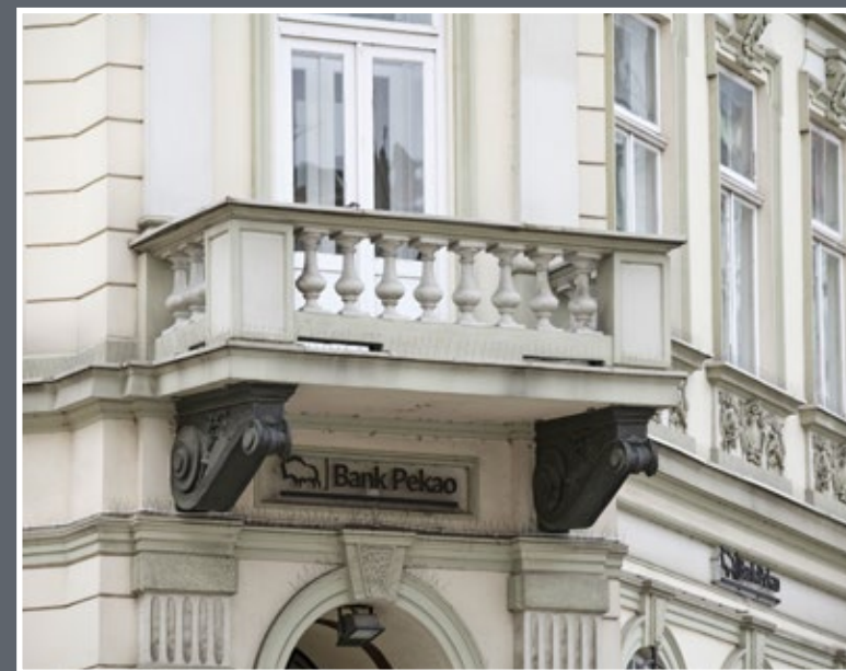
10 Balkon w narożu budynku Towarzystwa Kredytowego przy ul. Mickiewicza 6 wsparty na żeliwnych wspomnikach w formie konsol
