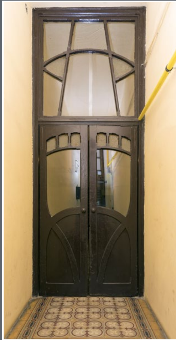
15 Drzwi z sieni do klatki schodowej w kamienicy przy ul. Franciszkańskiej 19
