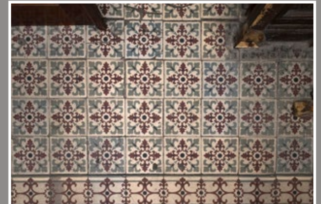
38 Posadzka klatki schodowej w kamienicy przy ul. Jagiellońskiej 27
