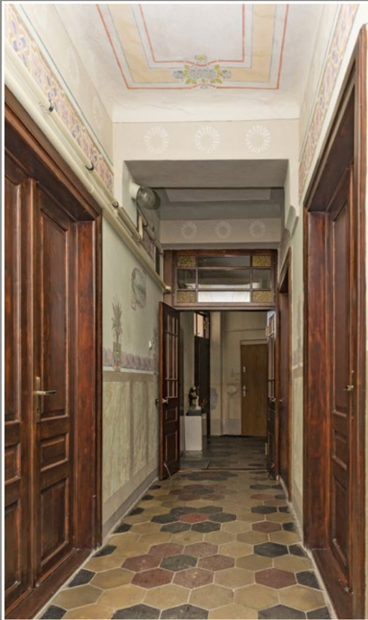
1 Terakotowa posadzka w kamienicy przy ul. Grzegorza z Sanoka 9 układana we wzór kwiatowy
