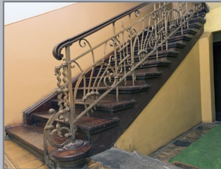
30 Balustrada schodów w kamienicy przy ul. Franciszkańskiej 17
