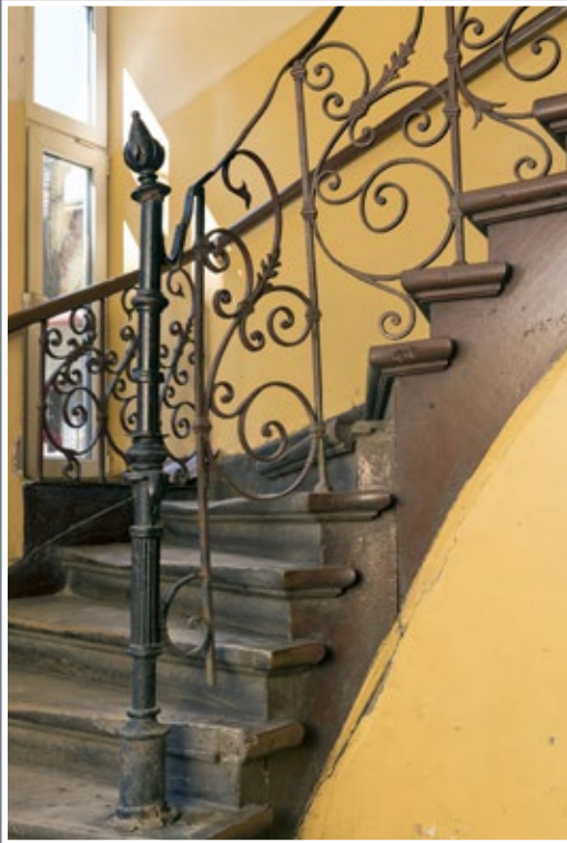
12 Słupek przy wejściu na schody w kamienicy przy ul. Słowackiego 10
