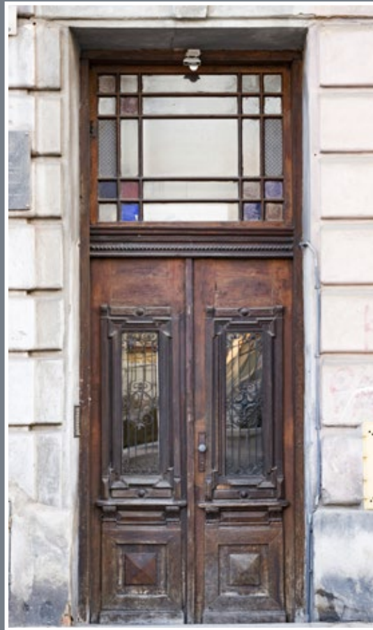
21 Drzwi w kamienicy przy ul. Dworskiego 46 z niezachowanymi naczółkami skrzydeł i starym oszkleniem nadświetla
