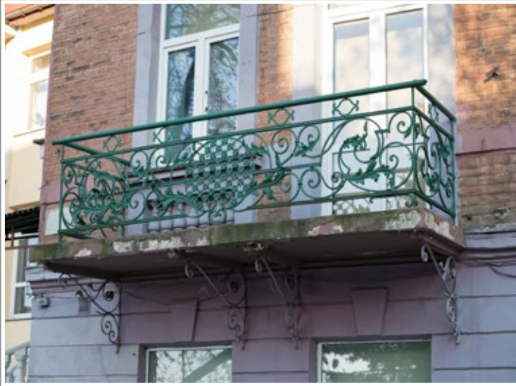
52 Balkon I piętra kamienicy przy ul. Sienkiewicza 11
