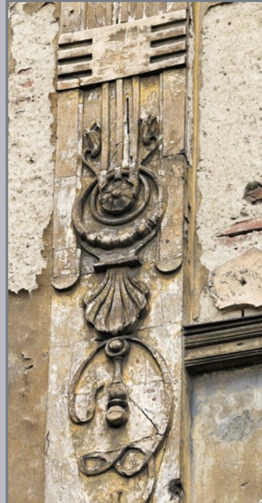
64 Detal wystroju elewacji kamienicy przy ul. Basztowej 12
