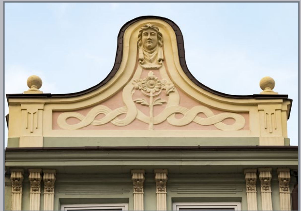
37 Zwieńczenie kamienicy przy ul. Grunwaldzkiej 4 z motywem kobiecej głowy
