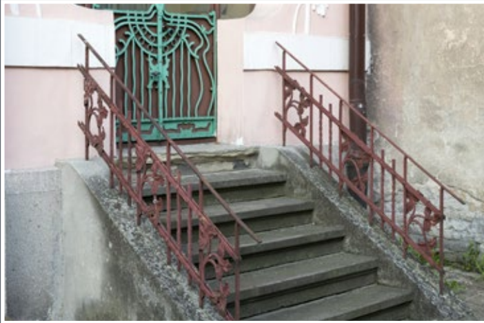
130 Schody zewnętrzne do willi „Marya” przy ul. Słowackiego 27 z kutą balustradą dekorowaną dużymi, repusowanymi w blaszce kwiatami
