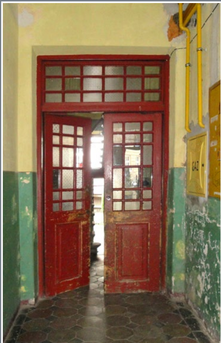
8 Drzwi do klatki schodowej w kamienicy przy ul. św. Józefa 11
