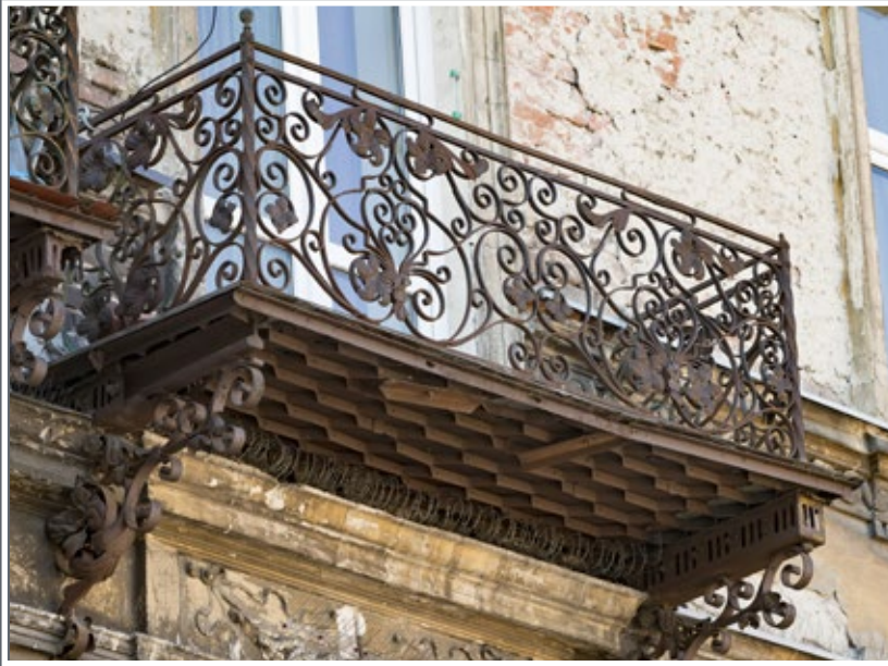
29 Balkon w kamienicy przy ul. Konarskiego 4
