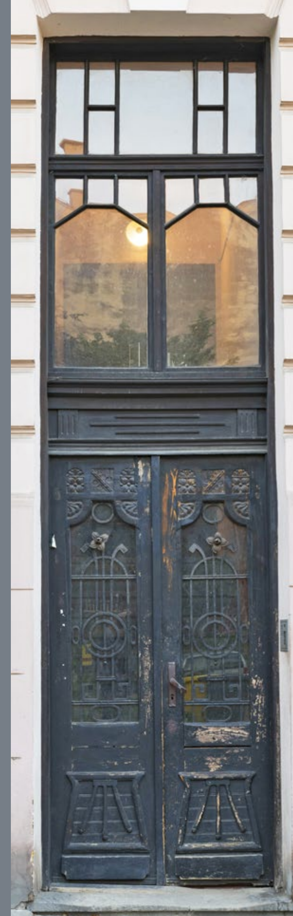
48 Drzwi w kamienicy przy ul. Rejtana 4 z wysokim nadświetlem; geometryczna ornamentacja skrzydeł została wzbogacona w zwieńczeniu dekoracją roślinną
