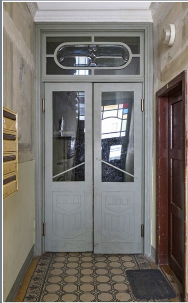
12 Drzwi z sieni do klatki schodowej w kamienicy przy ul. Frankowskiego 2
