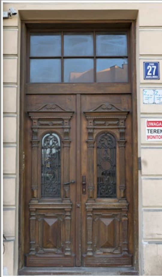
24 Drzwi w kamienicy przy ul. Jagiellońskiej 27 z zachowaną starą klamką
