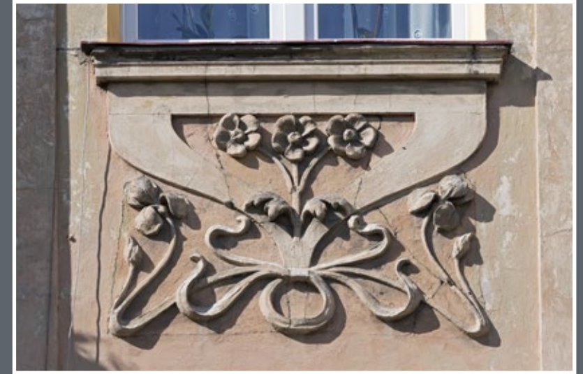
60 Ornament płyciny podokiennej elewacji kamienicy przy ul. Długosza 6
