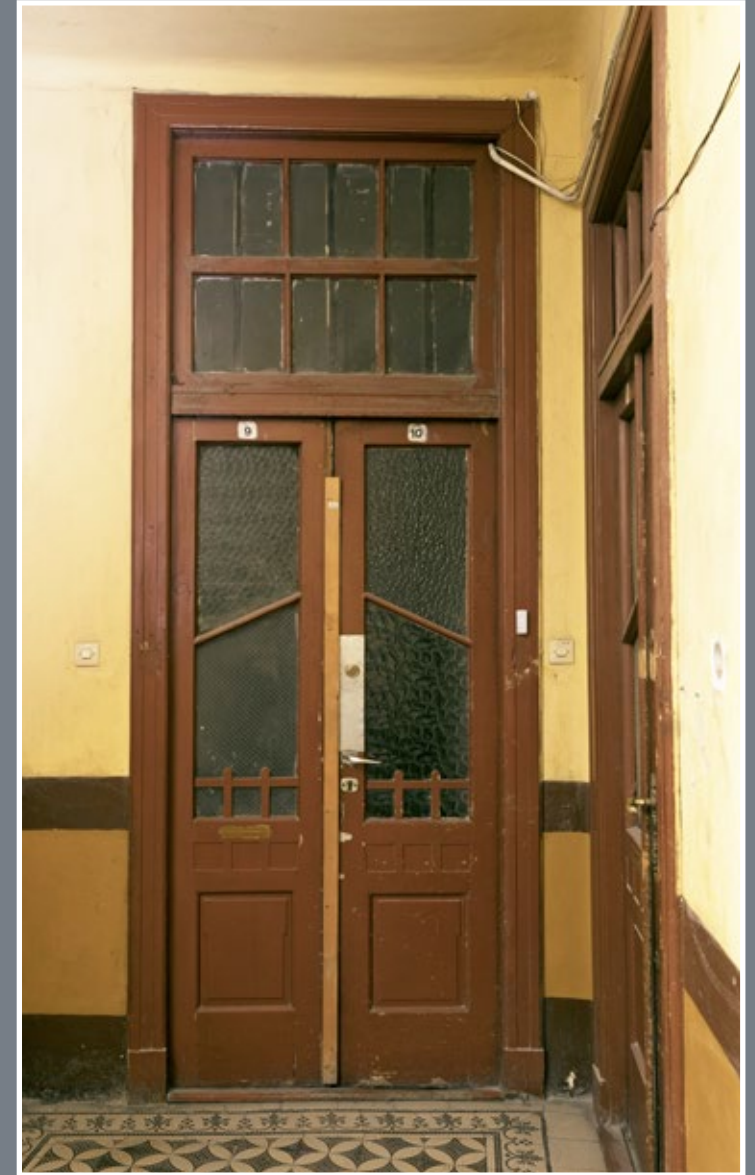
36 Drzwi do mieszkania w kamienicy przy ul. Śmigurskiego 9
