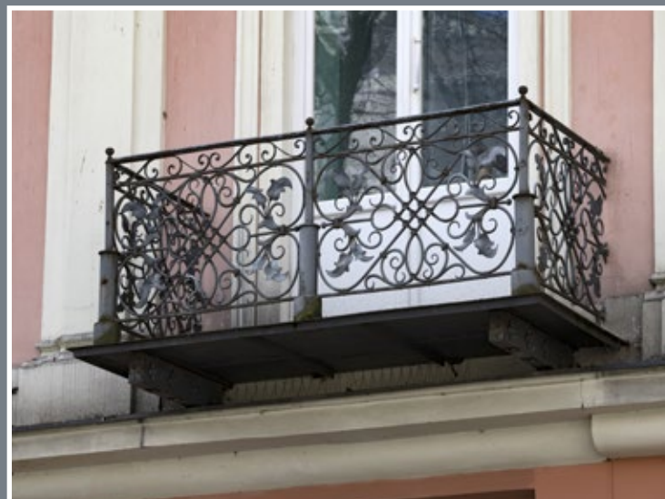
43 Balkon w kamienicy przy ul. Franciszkańskiej 16
