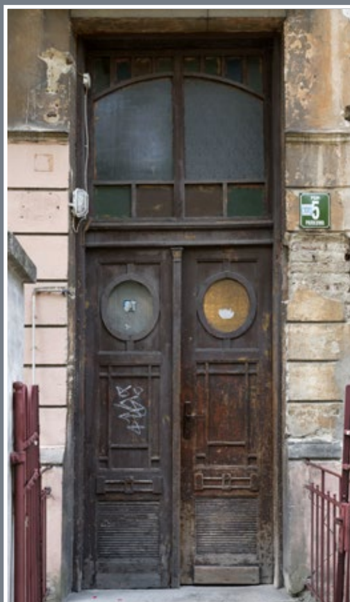
46 Drzwi w kamienicy przy ul. Parkowej 5 z częściowo zachowanym oszkleniem nadświetla
