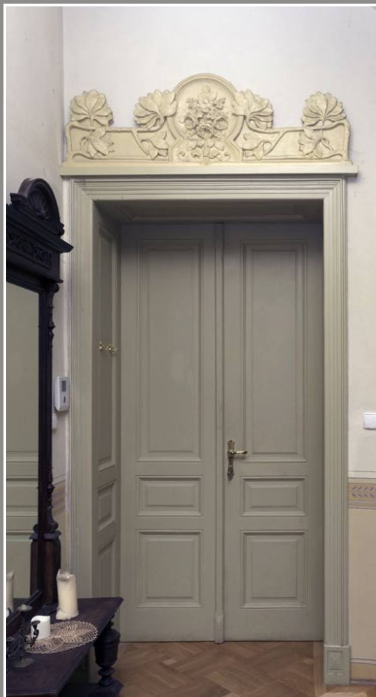
31 Klasycystyczne w wyrazie drzwi wewnętrzne do pokoju w budynku przy ul. Szopena 18 ozdobione gipsową supraportą o secesyjnym charakterze z motywami roślinnymi
