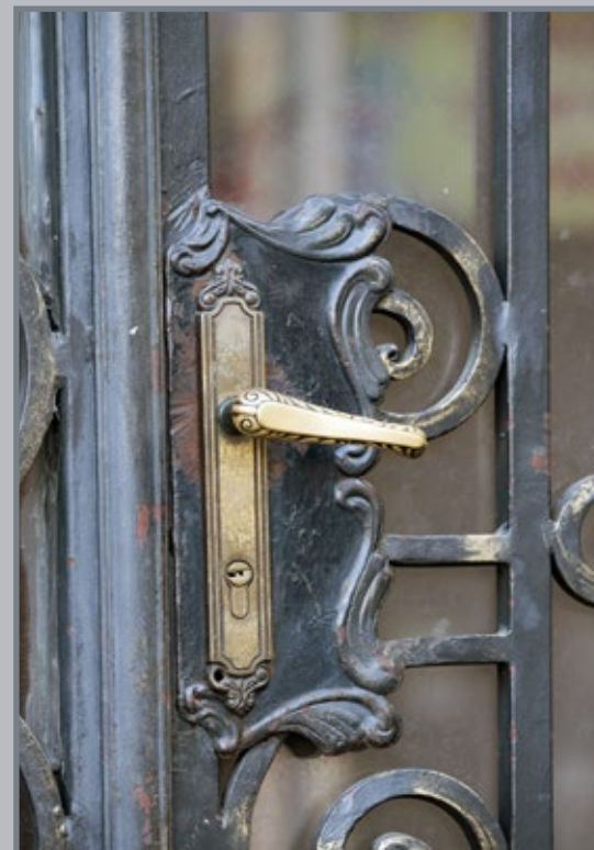
105 Szyld zamku i klamką we wrotach przejazdu w budynku przy ul. Mickiewicza 4
