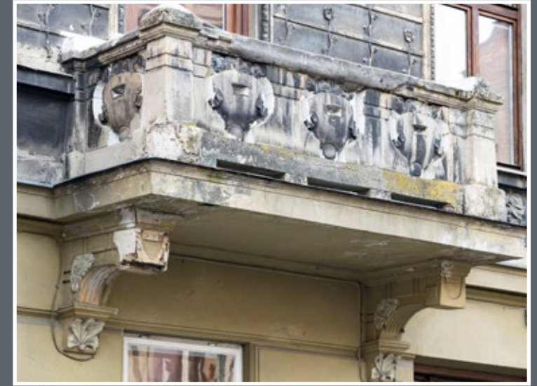
71 Nietypowy balkon w kamienicy przy ul. Puszkina 8a z cementową balustradą w formie tarcz z liśćmi laurowymi i z otworami na orły, których wizerunki znajdowały się od frontu
