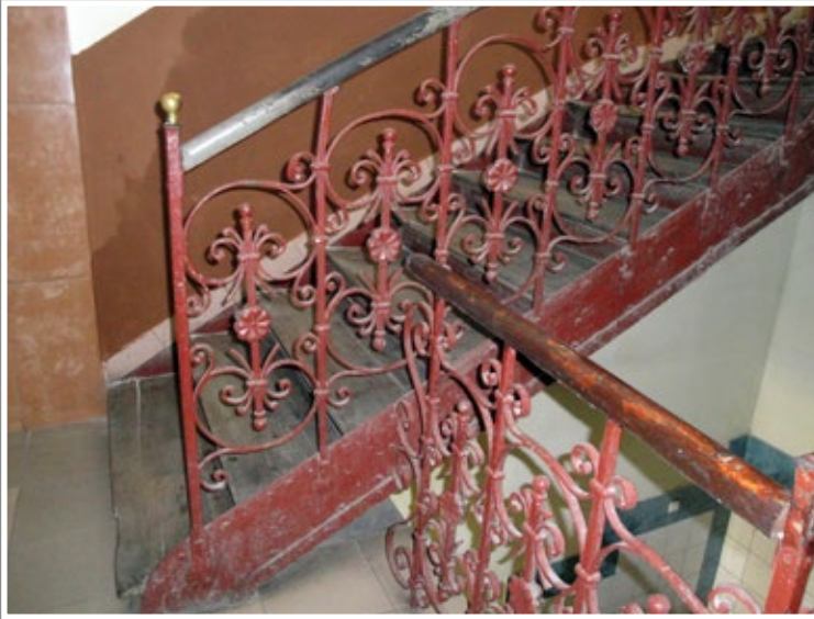
18 Balustrada schodów w kamienicy przy ul. Słowackiego 2
