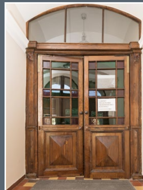
4 Drzwi z sieni do klatki schodowej w kamienicy przy ul. Grotgiera 4
