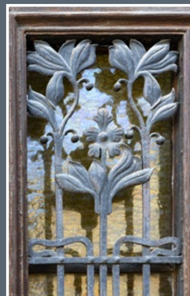
51 Drzwi w willi „Marya” przy ul. Słowackiego 27 w elewacji bocznej, z prześwitami skrzydeł przeszklonymi szkłem ornamentowym i secesyjnymi kratami o dekoracji z repusowanych w blasze kwiatów
