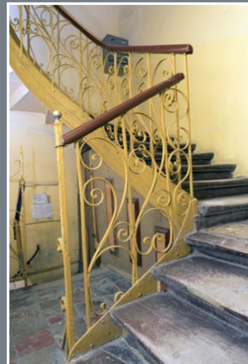
16 Balustrada schodów w kamienicy przy ul. Asnyka 6
