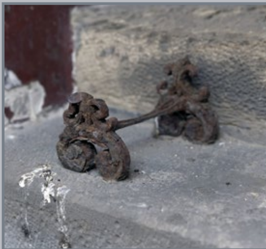
110 Wycieraczka do butów na schodach wejściowych do kamienicy przy ul. Smolki 15
