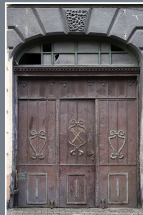
82 Żelazne wrota w kamienicy przy ul. 3 Maja 39 z 1889 roku z zachowanym starym szyldem zamku z klamką
