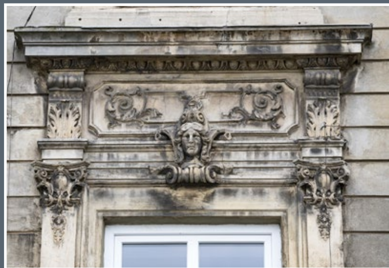
5 Sztukatorska oprawa okna kamienicy przy ul. Dworskiego 40
