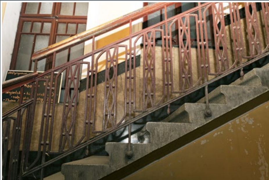
57 Balustrada schodów w kamienicy przy ul. Franciszkańskiej 37
