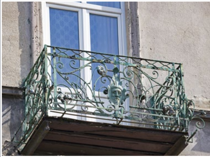
32 Balkon II piętra kamienicy przy ul. Słowackiego 3 z maszkaronem w centrum
