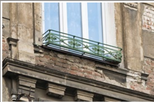
78 Skrzynka na kwiaty w kamienicy przy ul. Kopernika 3
