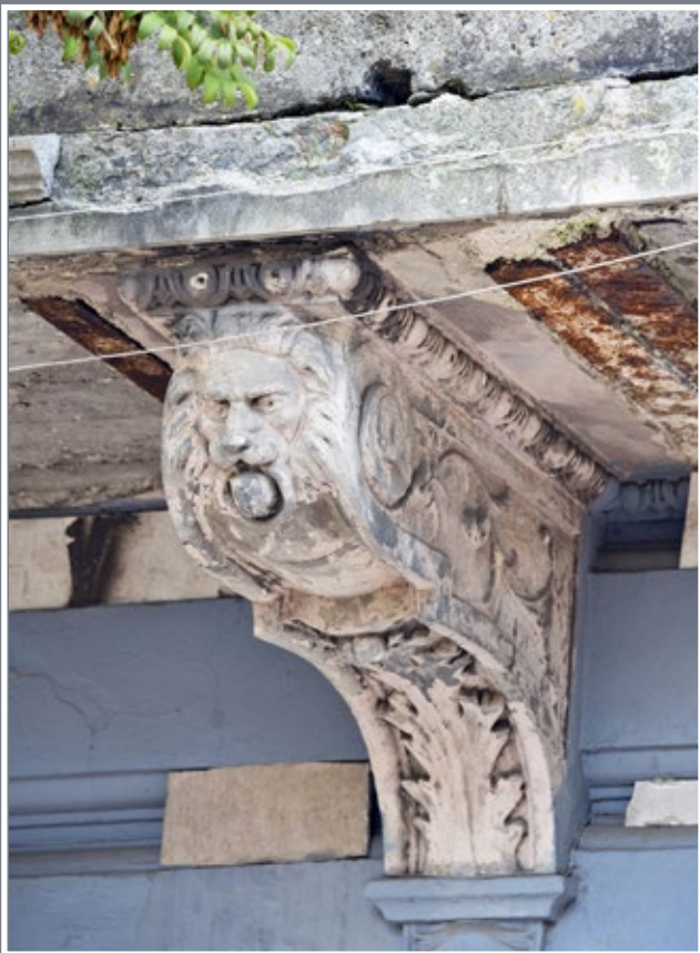
13 Wspornik balkonu I piętra kamienicy przy ul. Czarnieckiego 3 ozdobiony głową lwa
