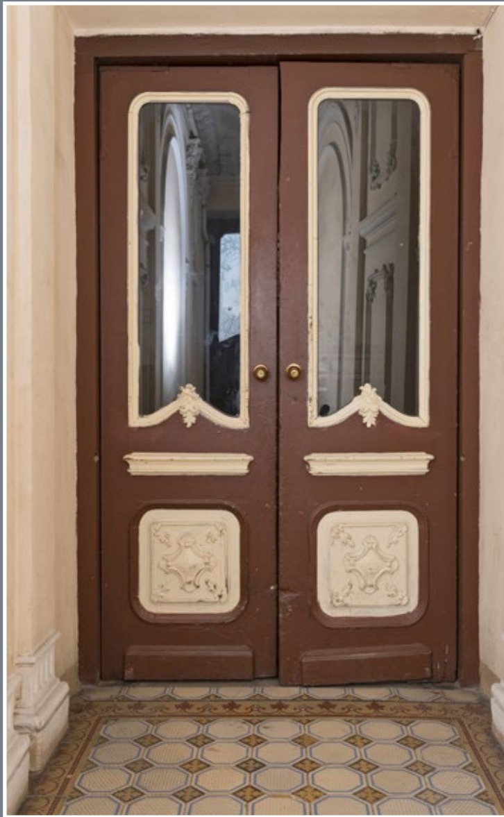
11 Drzwi z sieni do klatki schodowej w kamienicy przy ul. Dworskiego 40
