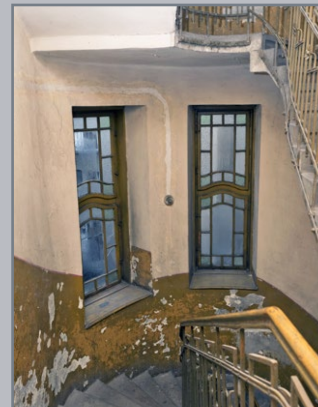
45 Okna klatki schodowej w kamienicy przy ul. Długosza 6 z częściowo zachowanym oryginalnym oszkleniem szkłem ornamentowym
