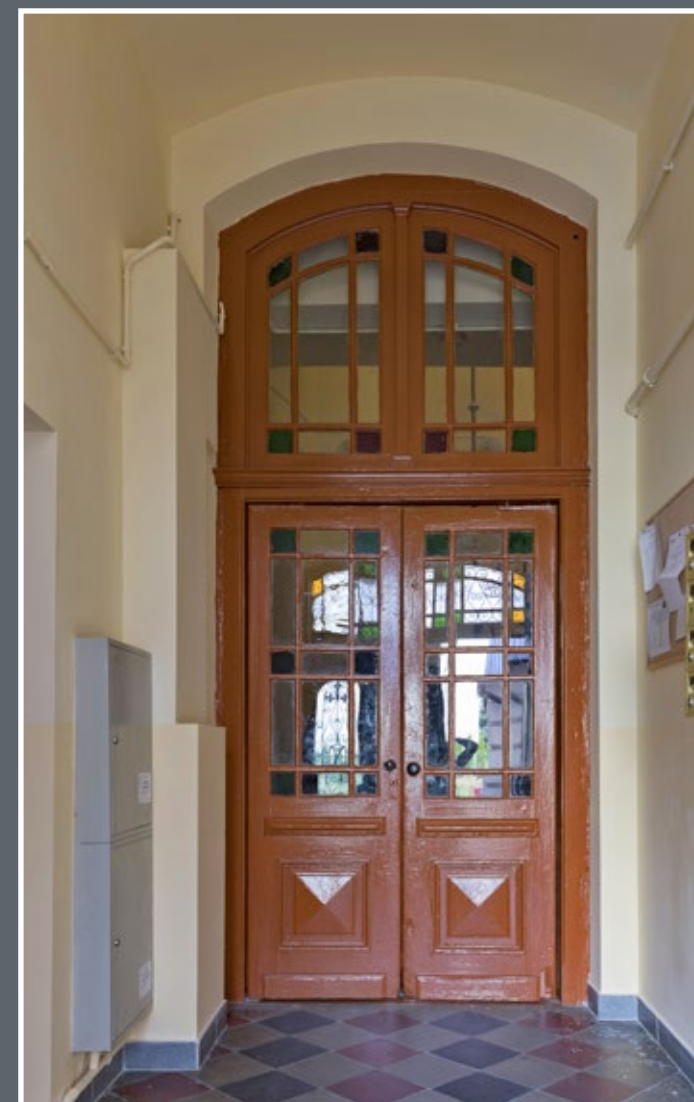
7 Drzwi do klatki schodowej w kamienicy przy ul. Hoffmanowej 5 z zachowanym oszkleniem z kolorowych szybek
