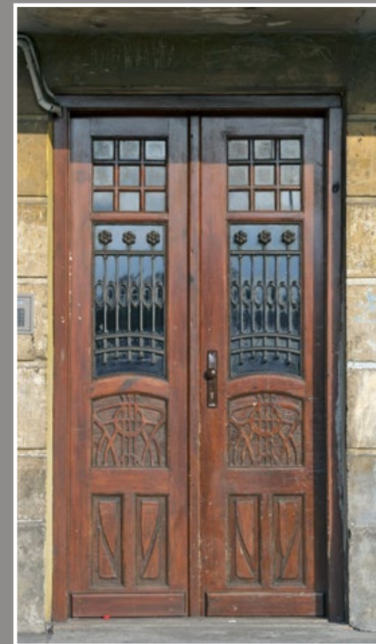
44 Drzwi w kamienicy przy ul. Parkowej 1
