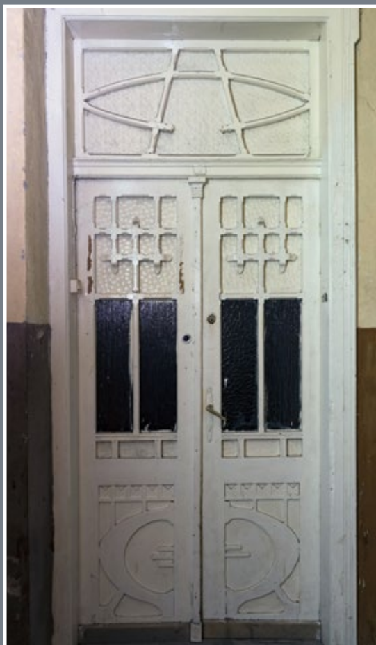
17 Drzwi z sieni do klatki schodowej w kamienicy przy ul. Dworskiego 58
