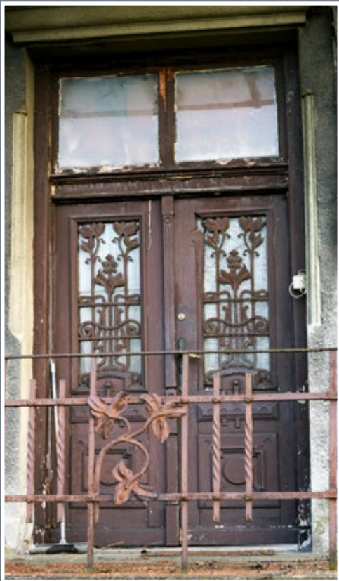
52 Drzwi w willi przy ul. Puszkina 15 z identycznymi w formie kratami prześwitów jak w willi „Marya”, różniącymi się jedynie szczegółami opracowania
