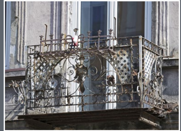
34 Balkon I piętra kamienicy przy ul. Słowackiego 3 z maszkaronem, o formie jak powyższy, ale różniący się szczegółami, jak również zachowaną oryginalną skrzynką na kwiaty z dekoracją w formie lilijek
