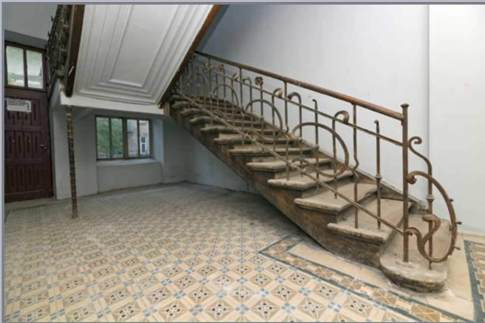
34 Balustrada schodów w kamienicy przy ul. Łukasińskiego 10
