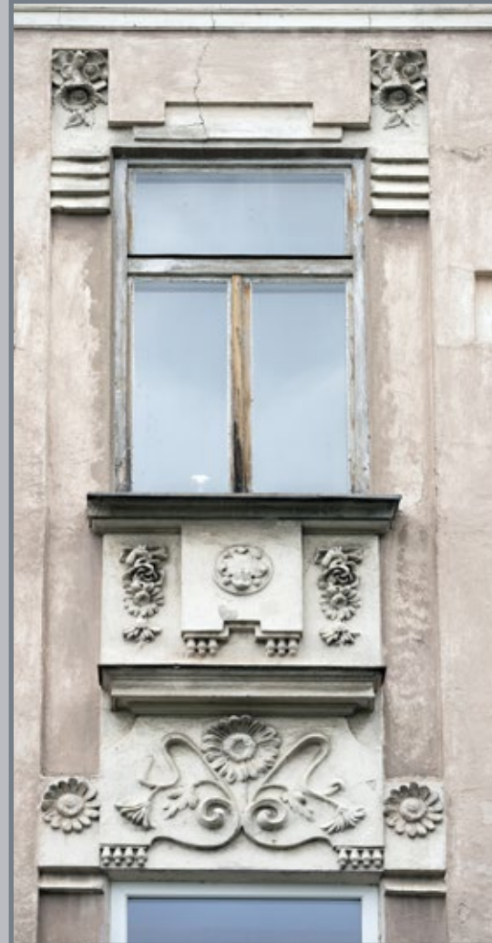
63 Opracowanie okien kamienicy przy ul. Raclawickiej 2
