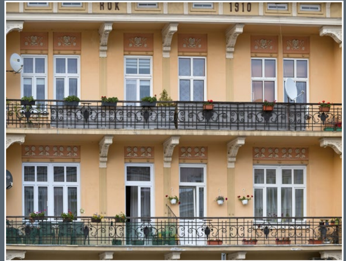
53 Dekoracja loggii I i II piętra kamienicy przy ul. Grunwaldzkiej 6
