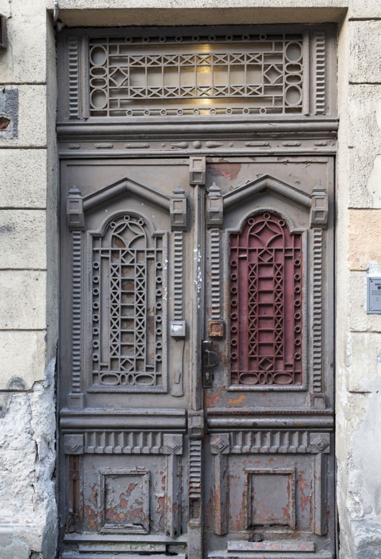
92 Żelazne drzwi w kamienicy przy ul. Słowackiego 23 o formie powtarzającej schemat drzwi drewnianych z przełomu wieków XIX i XX
