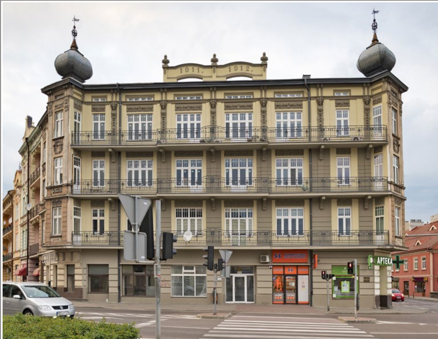
43 Kamienica przy pl. Konstytucji 3 Maja 7 (z wejściami również od ul. Grunwaldzkiej 2 i 3 Maja 1) wzniesiona w 1912 roku według projektu Marcellego Pileckiego
