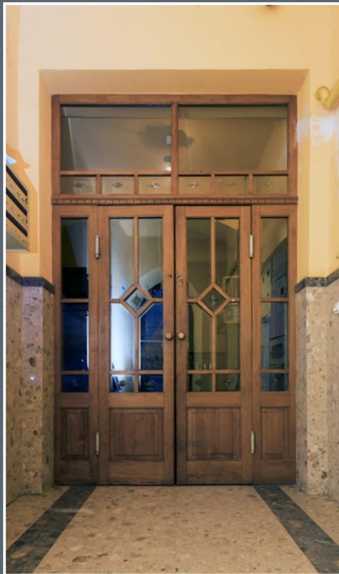
2 Ścianka z drzwiami z sieni do pomieszczeń w kamienicy przy ul. Sowińskiego 1
