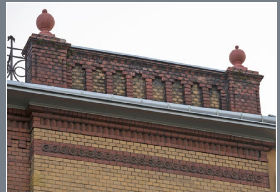
79 Ceramiczny fryz z rozet na elewacji kamienicy przy ul. Słowackiego 32
