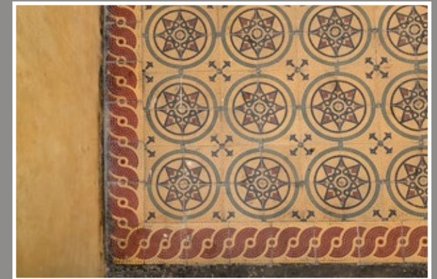
36 Posadzka najwyższego podestu schodów w kamienicy przy ul. Dworskiego 40
