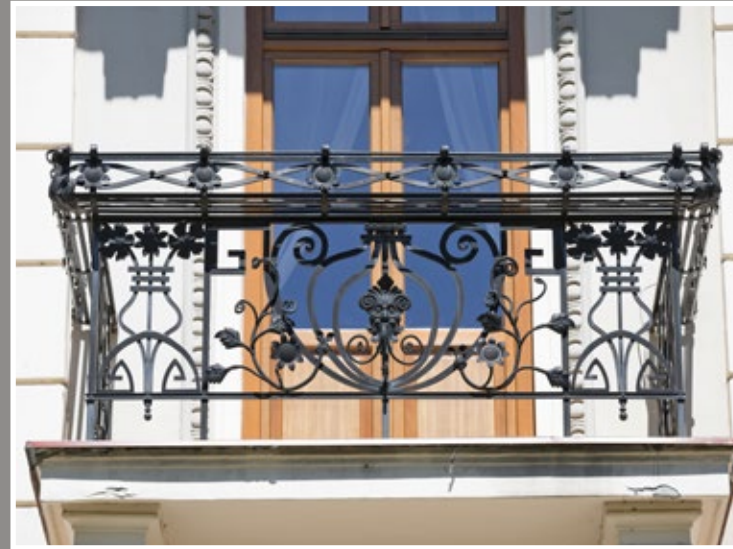
56 Balkon w kamienicy przy ul. Skargi 6
