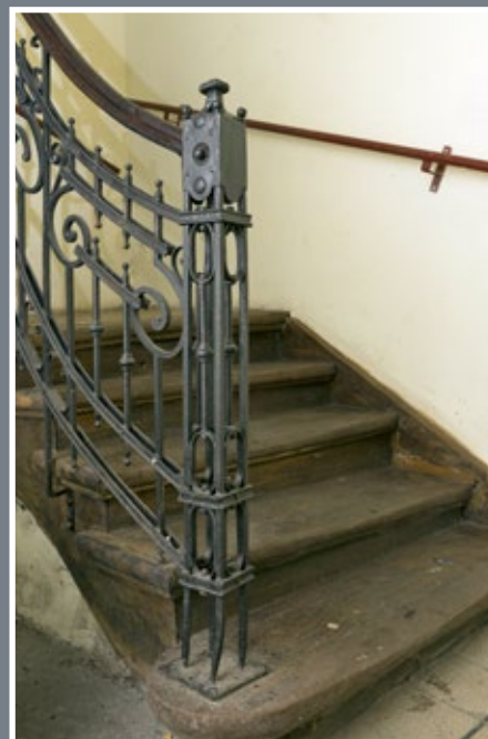
37 Balustrada schodów w kamienicy przy ul. Kazimierza Wielkiego 18
