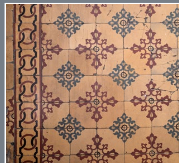
46 Posadzka w sieni kamienicy przy ul. Tarnawskiego 12
