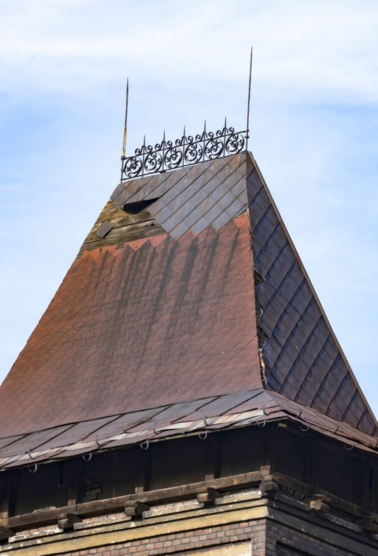
123 Balustrada na kalenicy wieżyczki willi przy ul. Okrzei 18
