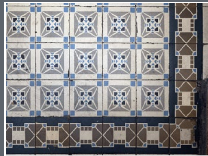
57 Posadzka sieni i klatki schodowej w kamienicy przy ul. Słowackiego 63
