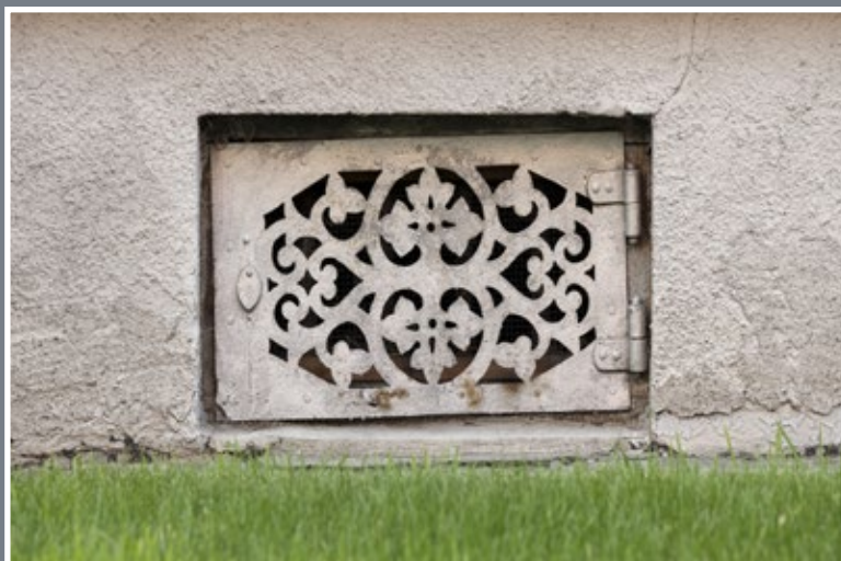
137 Krata okna piwnicznego w budynku przy ul. 3 Maja 18
