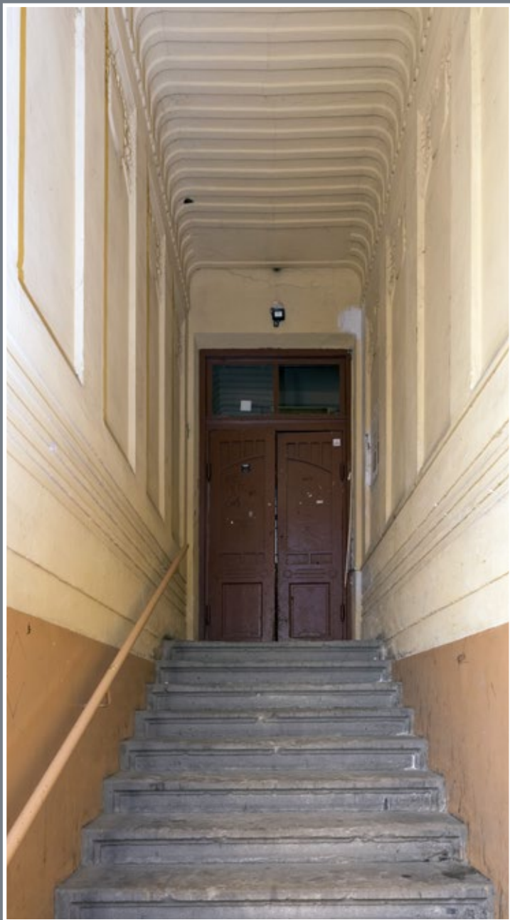
10 Dekoracja sieni i przejźdu w kamienicy Izraela Nussbauma przy ul. Słowackiego 64
