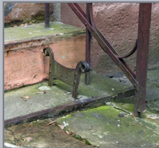
112 Wycieraczka do butów na schodach wejściowych do budynku przy ul. Skargi 8
