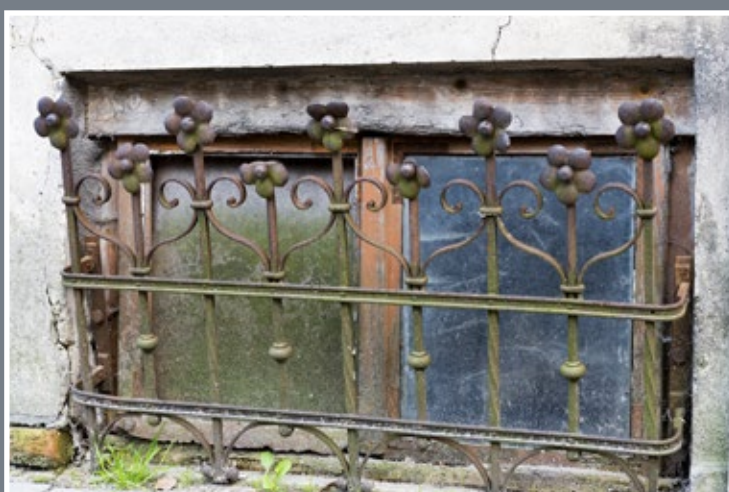
140 Krata okienka piwnicznego w kamienicy przy ul. Kopernika 12
