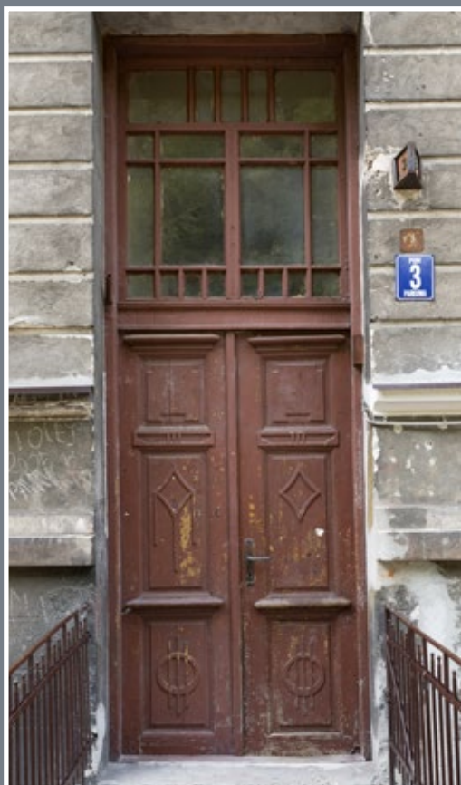
45 Drzwi w kamienicy przy ul. Parkowej 3
