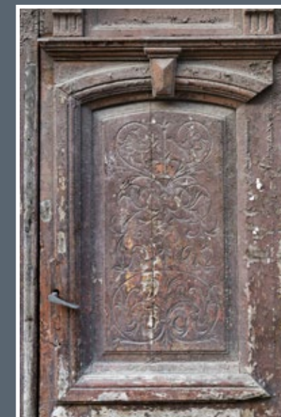
12 Szerokie wrota do sieni-przejazdu kamienicy przy ul. Dworskiego 51, z płycinami ozdobionymi rytą dekoracją roślinną
