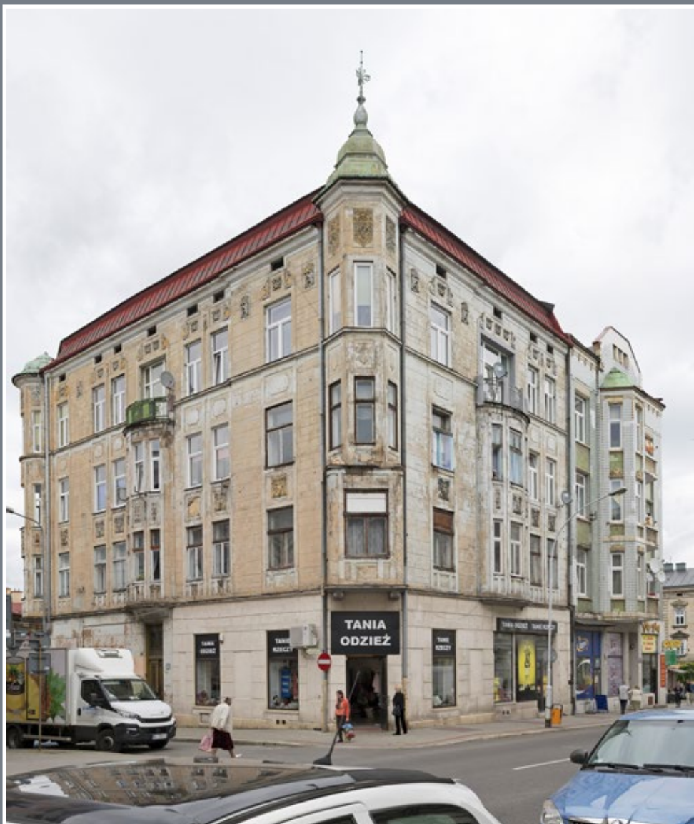
73 Kamienica Leopolda Süssweina narożnie usytuowana przy ul. Mickiewicza 1/Sowińskiego 2, wzniesiona w 1912 roku
