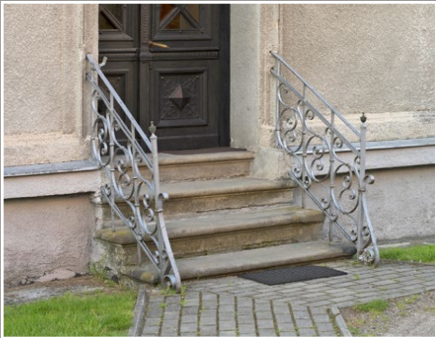
135 Schody zewnętrzne w budynku przy ul. 3 Maja 18
