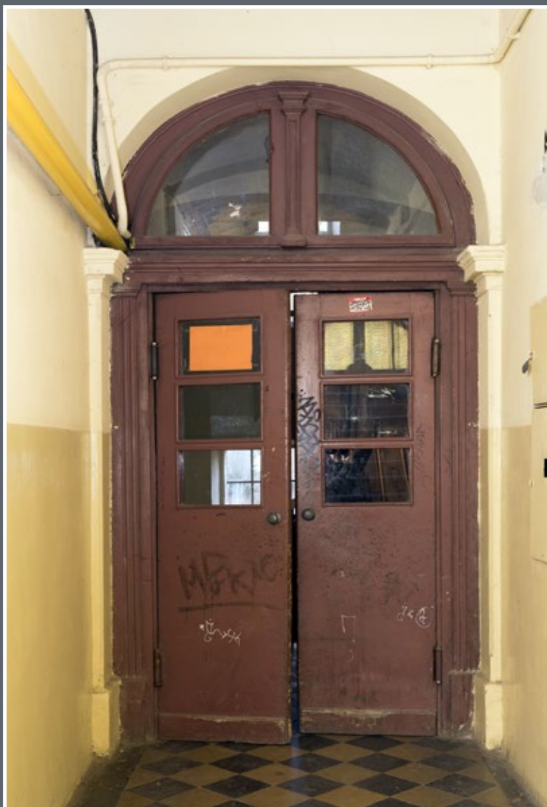
5 Drzwi z sieni do klatki schodowej w kamienicy przy ul. 3 Maja 14 (skrzydła przekształcone)
