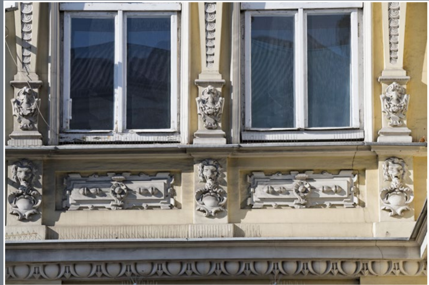
14 Dekoracja okien I piętra kamienicy przy ul. Jagiellońskiej 21 z motywem lwich głów
