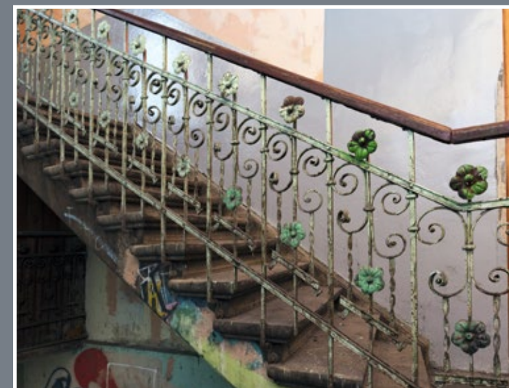
41 Balustrada schodów w kamienicy przy ul. Grunwaldzkiej 41b
