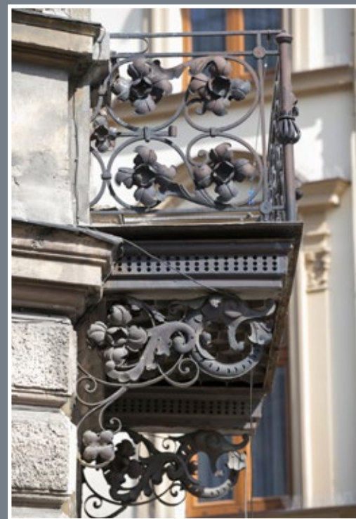
21 Balkon I piętra kamienicy przy ul. Dworskiego 9/ Rejtana o kutej balustradzie z motywem dużych, repusowanych w blasze kwiatów, wsparty na ażurowej, metalowej czaszy i kutyh wspornikach z przedstawieniem smoków
