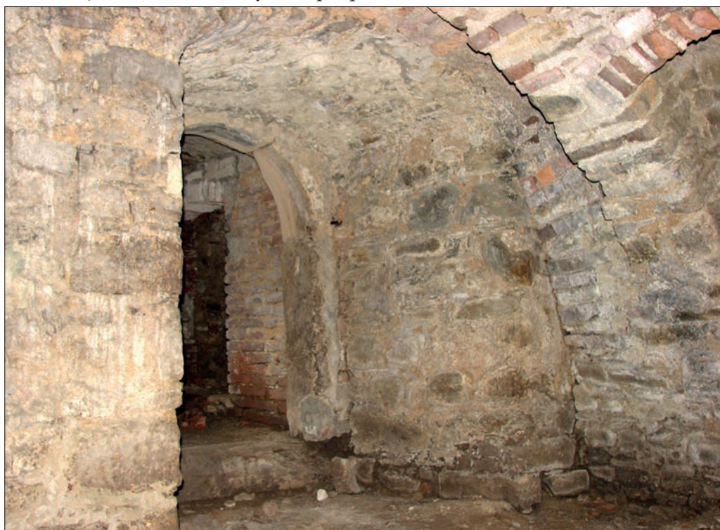
il. 19 Lamus w Hawłowicach Górnych, widok od wnętrza piwnicy na wnękę z portalem, w głębi przejście do komory na końcu korytarza zejściowego, z przodu po prawej uskok sklepienia; fot. J. Szyma.
