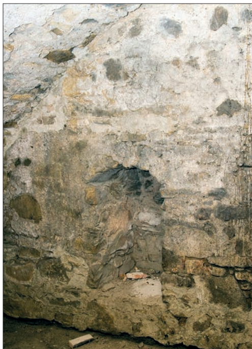
Il. 25. Lamus w Hawłowicach Górnych, piwnica, wylot pionu kominowego w ścianie wschodniej; fot. J. Szyma.
