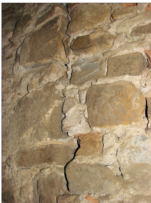
Il. 27. Lamus w Hawłowicach Górnych, styk muru obwodowego widocznego w szczycie okna w ścianie południowej (po lewej) i dostawionej do niej na styk powłoki sklepienia piwnicy (po prawej); fot. M. Szyma.
