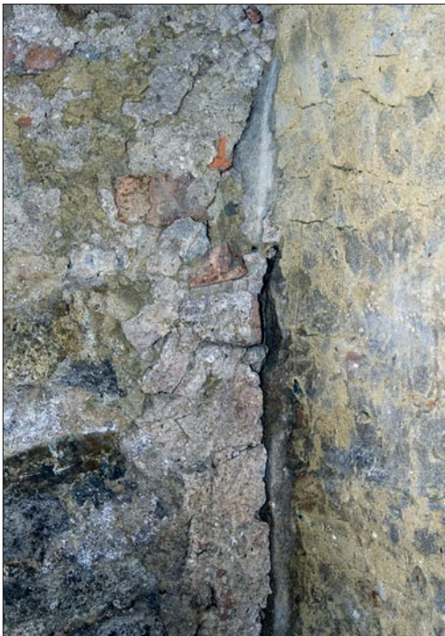
Il. 17 i 18. Lamus w Hawłowicach Górnych, komora na końcu korytarza do piwnicy. Widoczne od lewej: mur obwodowy piwnicy, ceglana zamurówka przebicia muru z krawędzią portalu, mur wydzielający komorę; fot. J. Szymba.
