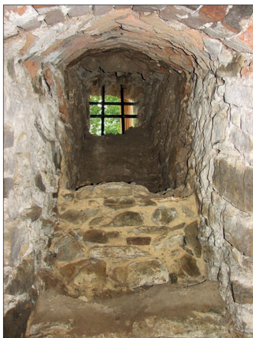
Il. 26. Lamus w Hawłowicach Górnych, wnętrze szczyty okna zachodniego w ścianie południowej; na wprost odsadzka w parapecie szczyty; fot. M. Szyma.
