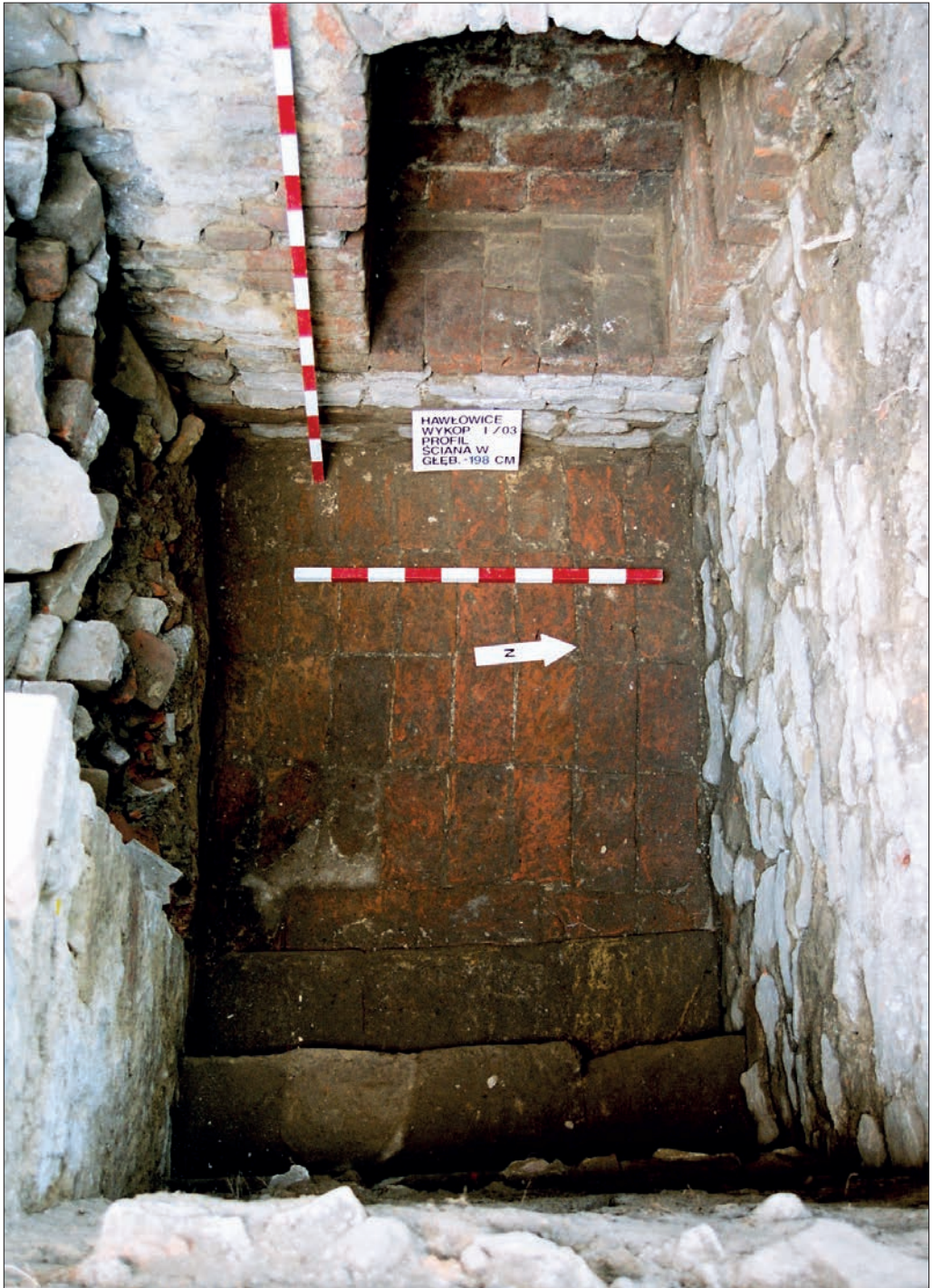
Il. 11. Ceglana posadzka we wnętrzu zejścia do piwnicy usytuowanego od strony północno-wschodniej dworu.
