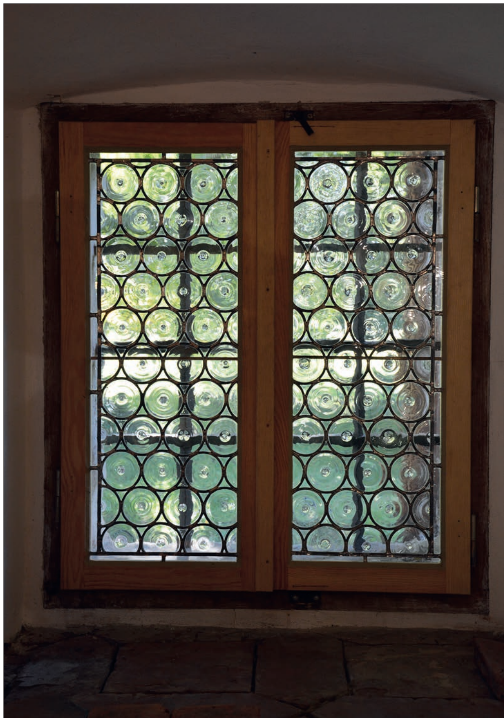
Il. 16. Zrekonstruowane gomółkowe przeszklenie okien.
