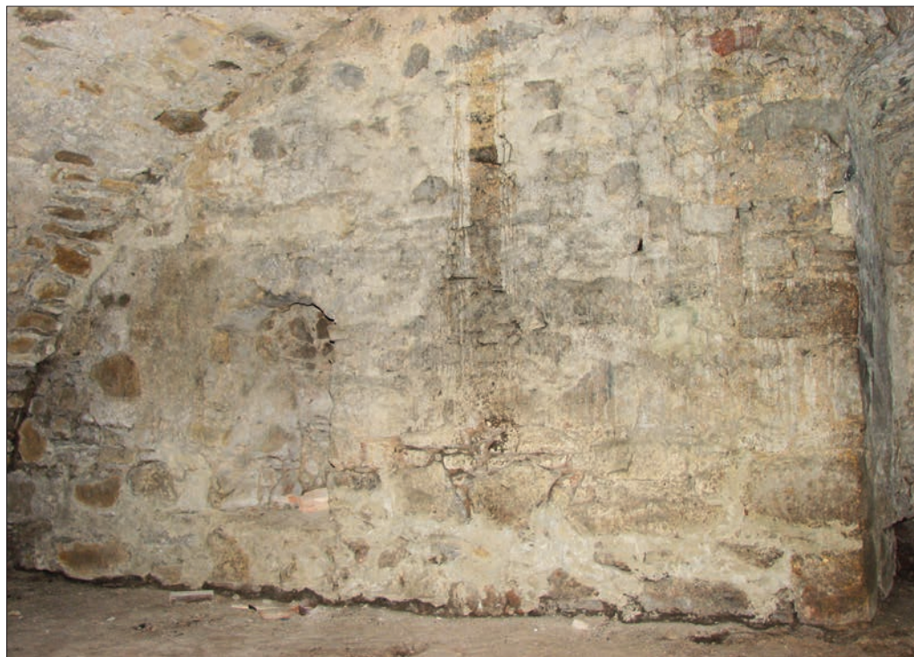
Il. 20. Lamus w Hawłowicach Górnych, piwnica, ściana wschodnia. Widoczny wylot pionu kominowego oraz krawędź wnęki wejściowej do piwnicy; fot. J. Szyma.
