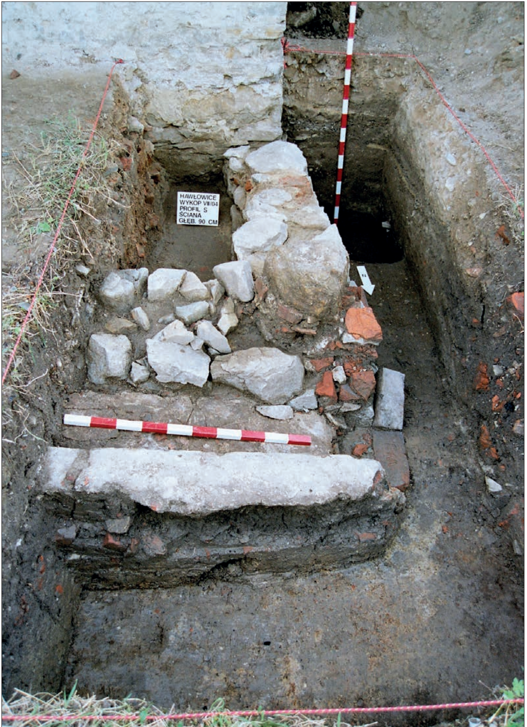
Il. 14. Narożnik fundamentu dobudówki dostawionego do ściany północnej budowli zasadniczej z widocznym kanalikiem ściekowym.
