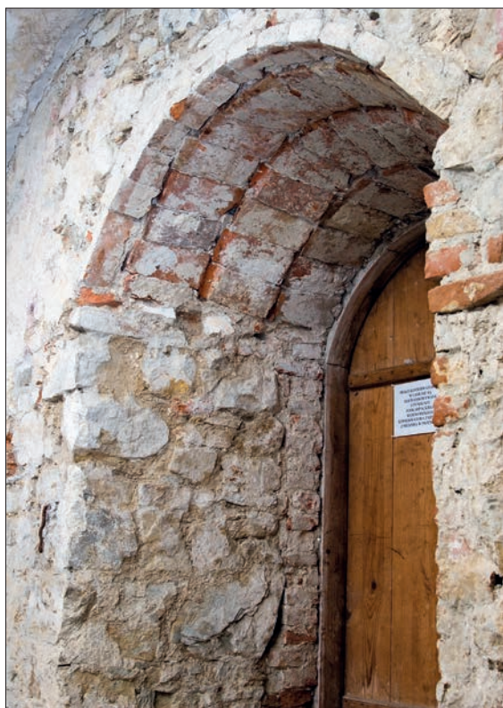
Il. 11. Lamus w Hawłowicach Górnych, wejście do sali parteru, widok od wnętrza, stan z 2005 r. Widoczny kamienny lewy gład otworu oraz prawy gład i nadproże z cegły; fot. J. Szyma.
