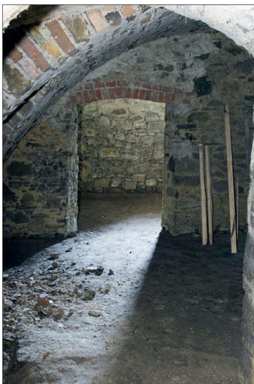
Il. 23. Lamus w Hawłowicach Górnych, widok wnętrza piwnicy przez portal. Widoczne wchodzenie sklepienia w światło wejścia i jej uskoki; fot. J. Szyma.
