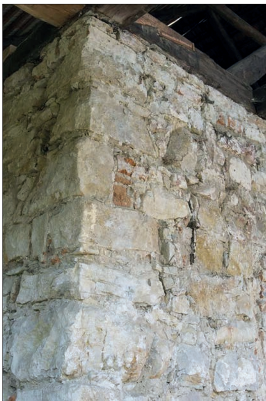
Il. 6. Lamus w Hawłowicach Górnych, narożnik południowo-zachodni; fot. J. Szyma.
