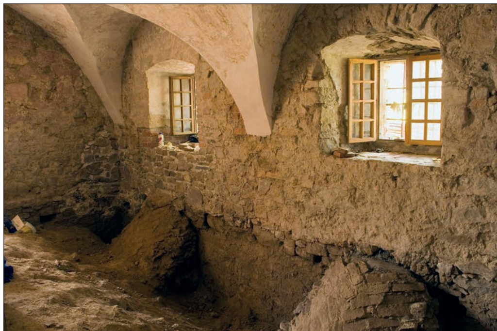
Il. 12. Lamus w Hawłowicach Górnych, sala parteru po skuciu tynków i zerwaniu posadzki, widok na ścianę południową, stan z 2005 r. Widoczne partie wążku w narożniku południowo-wschodnim, wymienione podczas prac konserwatorskich oraz grzbiety powłok sklepienia piwnicy i gniazda belek; fot. J. Szyma.
