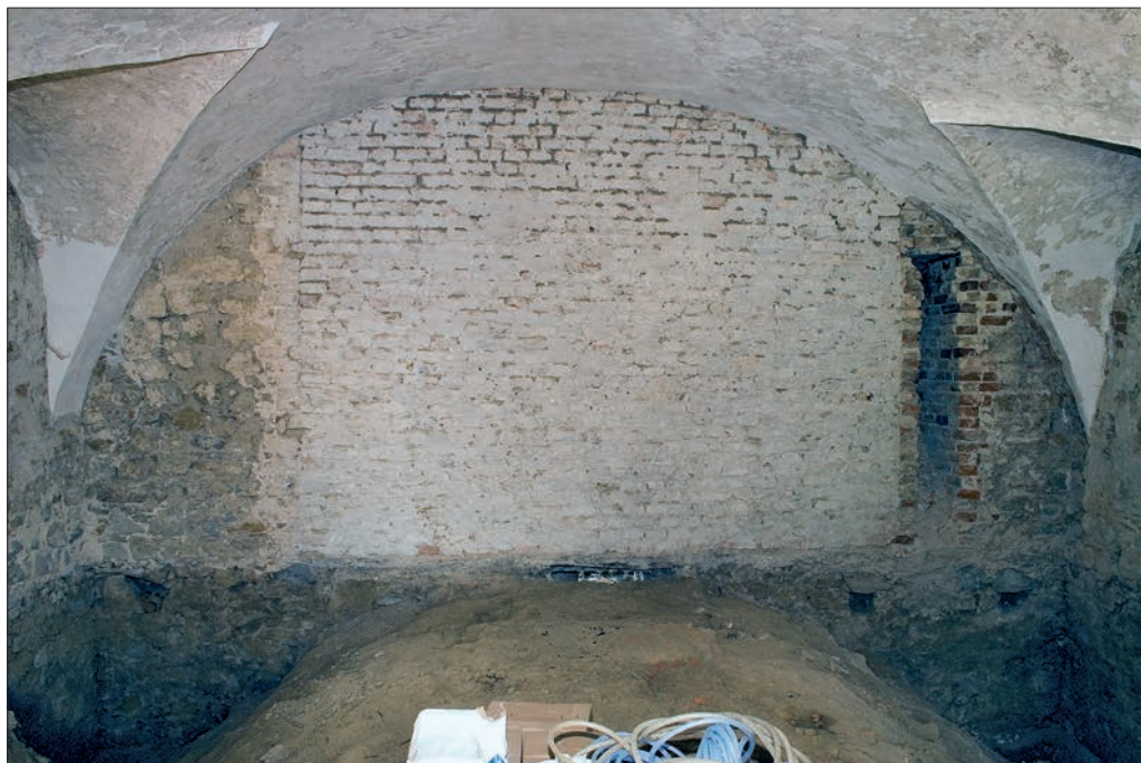
Il. 10. Lamus w Hawłowicach Górnych, sala parteru po skuciu tynków i zerwaniu posadzki, stan z 2005 r. Widoczne: sklepienie sali, grzbiet powłok sklepienia piwnicy, maczulce i odsadzka odkryte poniżej posadzki sali, ściana zachodnia z zamurówką po usunięciu prezbiterium, fragmentarycznie zachowana wnęka w pn. murze prezbiterium na sprzęty liturgiczne; fot. J. Szyma.
