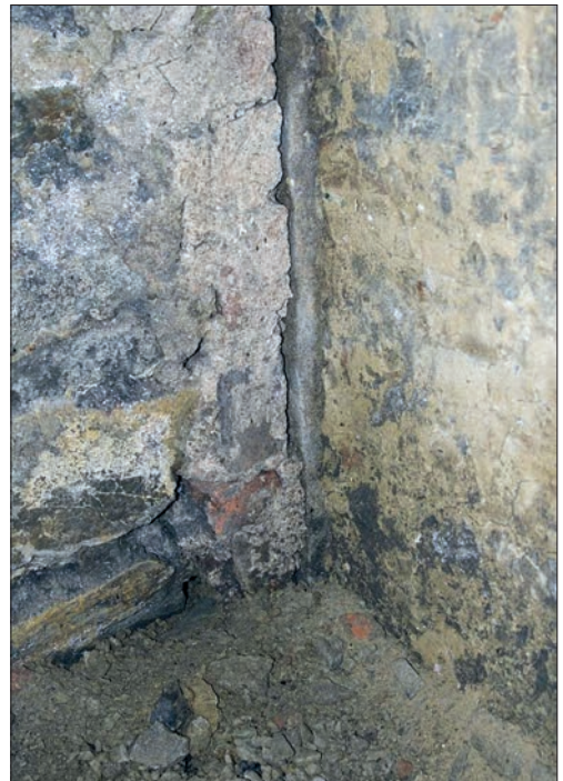
Il. 17 i 18. Lamus w Hawłowicach Górnych, komora na końcu korytarza do piwnicy. Widoczne od lewej: mur obwodowy piwnicy, ceglana zamurówka przebicia muru z krawędzią portalu, mur wydzielający komorę; fot. J. Szymba.
