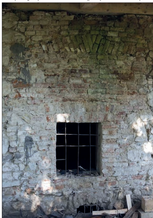
Il. 15. Lamus w Hawłowicach Górnych, elewacja południowa, okno wschodnie, stan z 2005 r.; fot. J. Szyma
