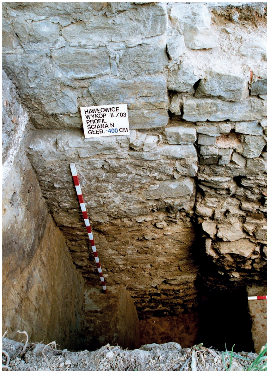
Il. 5. Narożnik południowo-wschodni fundamentu budowli zasadniczej. Widoczna odsadzka dzieląca partię nadziemną od fundamentowej.
