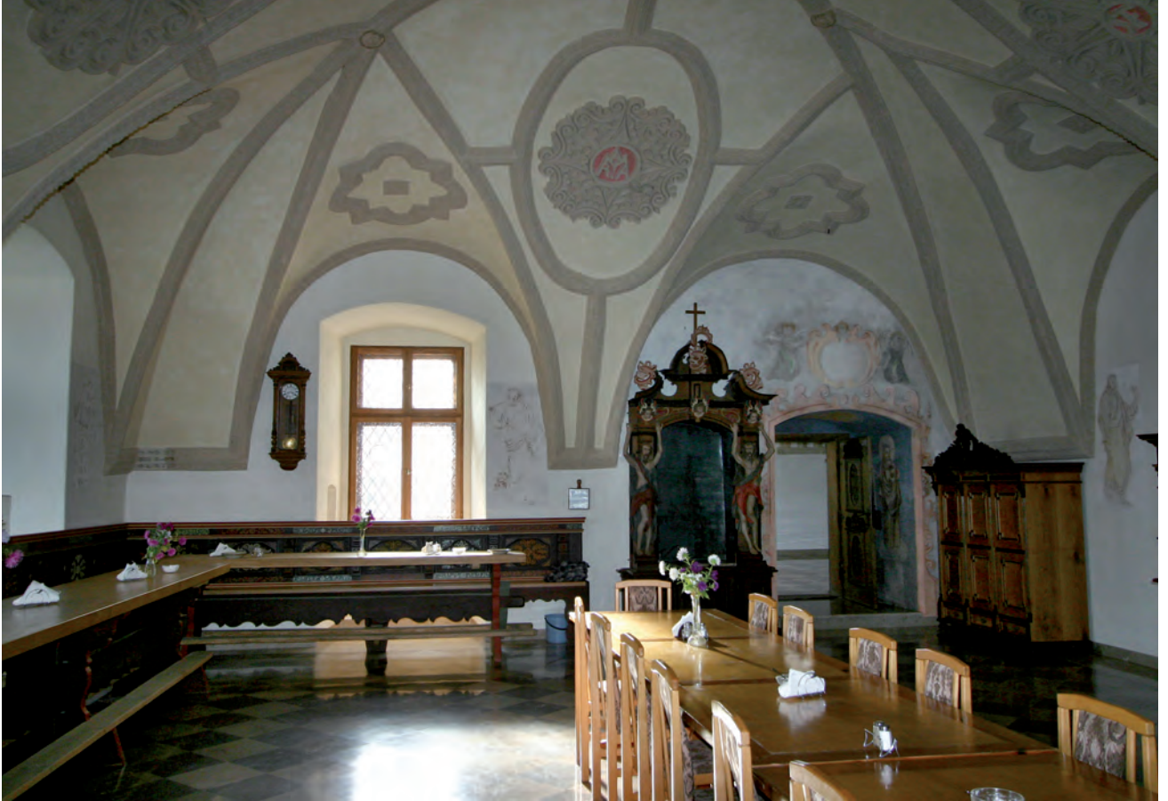
Refektarz klasztorny po zakończonych pracach. Fot. B. Podubny
