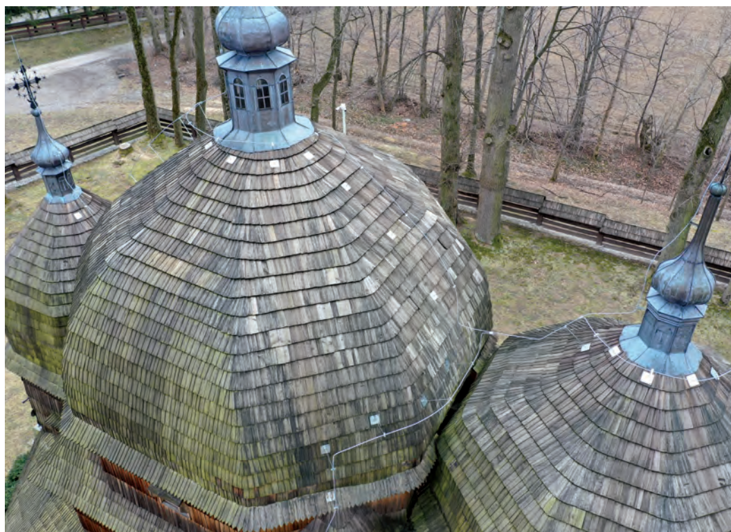
Cerkiew w Chotyńcu – widok na kopuły
