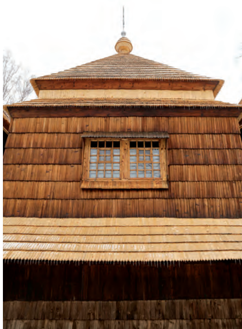
Cerkiew w Smolniku – fragment południowej ściany nawy
