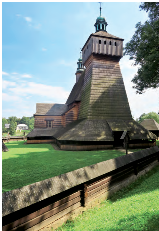
Kościół w Haczowie – wieża-dzwonnica, widok od północnego zachodu. Fot. M. Czuba
