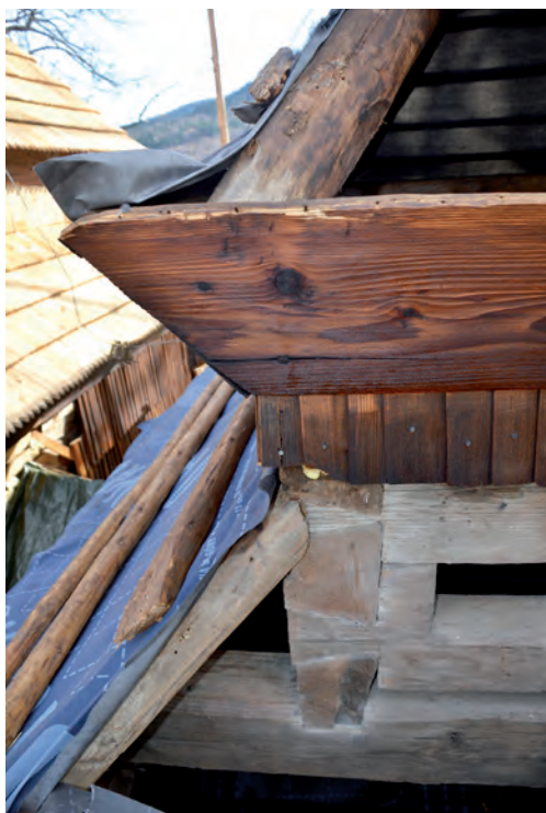
Zwęglowanie załomu wierzchu zachodniej części cerkwi
