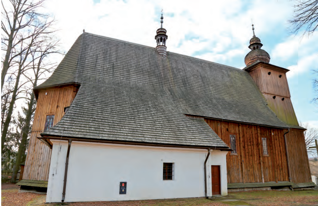
Łęki Górne, kościół pw. św. Bartłomieja Apostoła, elewacja północna z murowaną zakrystią
