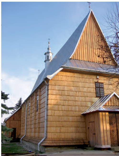
Widok ogólny na elewację frontową i północną
