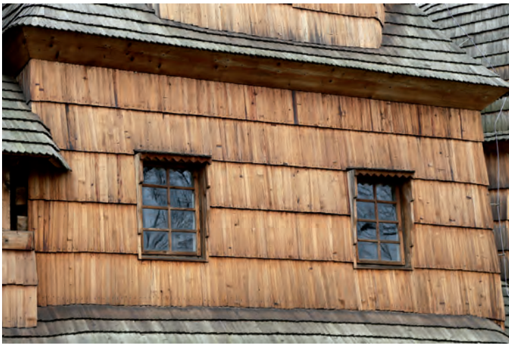
Cerkiew w Chotyńcu – fragment południowej ściany nawy
