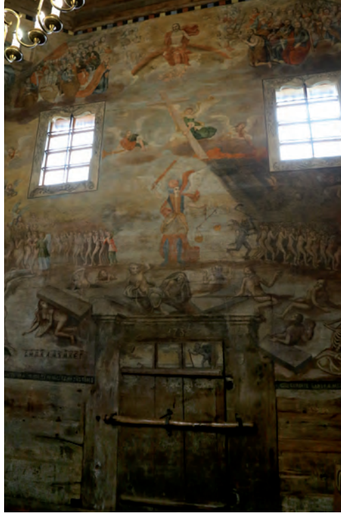
Cerkiew w Chotyńcu – południowa ściana nawy z malowidłem Sądu Ostatecznego z 1735 roku
